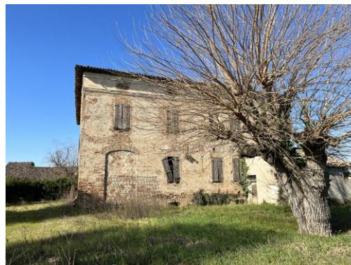
La struttura portante è in muratura, solai in arelle ed in parte in legno e tavelle (in parte divelti) manto in coppi di laterizio. Le facciate esterne sono interamente in mattoni faccia vista.
