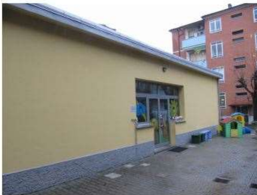
FOTO 03: vista da est
