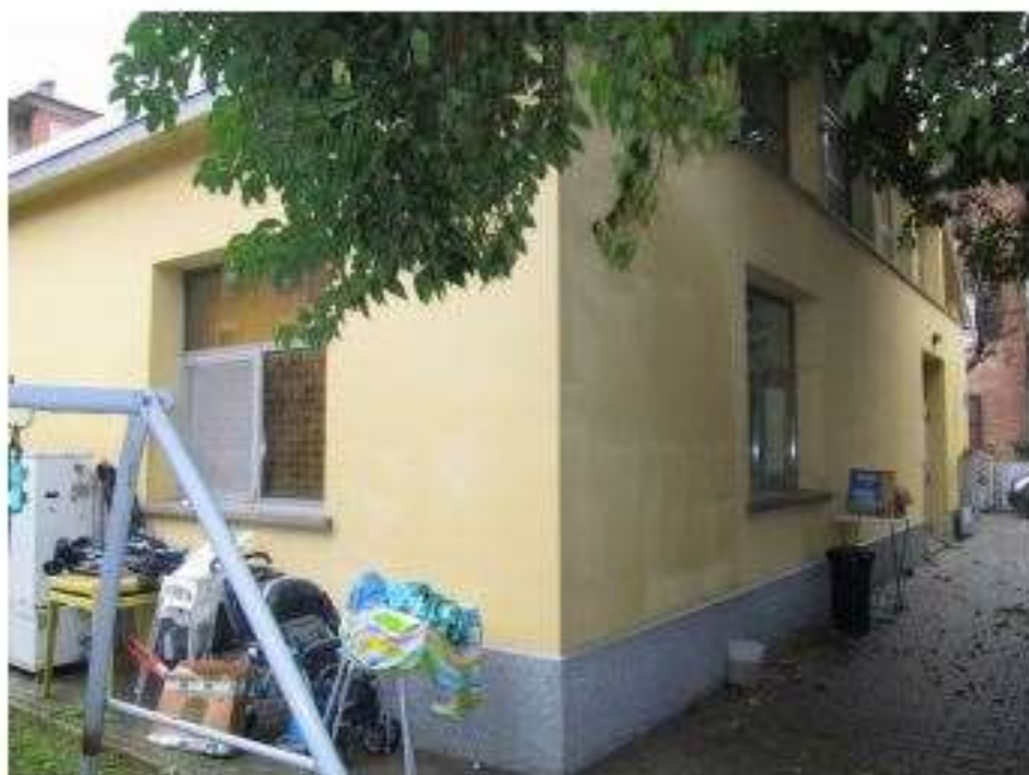
FOTO 06: vista da sud-ovest
