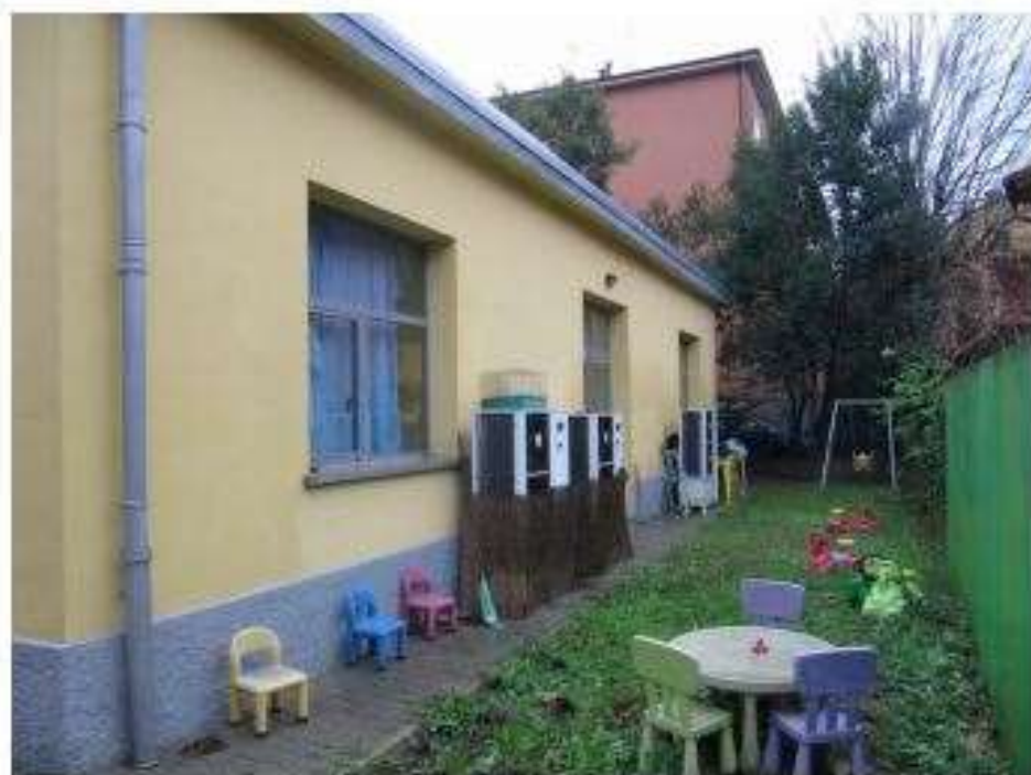
FOTO 05: vista da ovest
