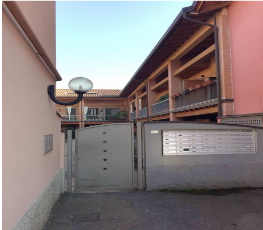
Ingresso da Via Mentana
