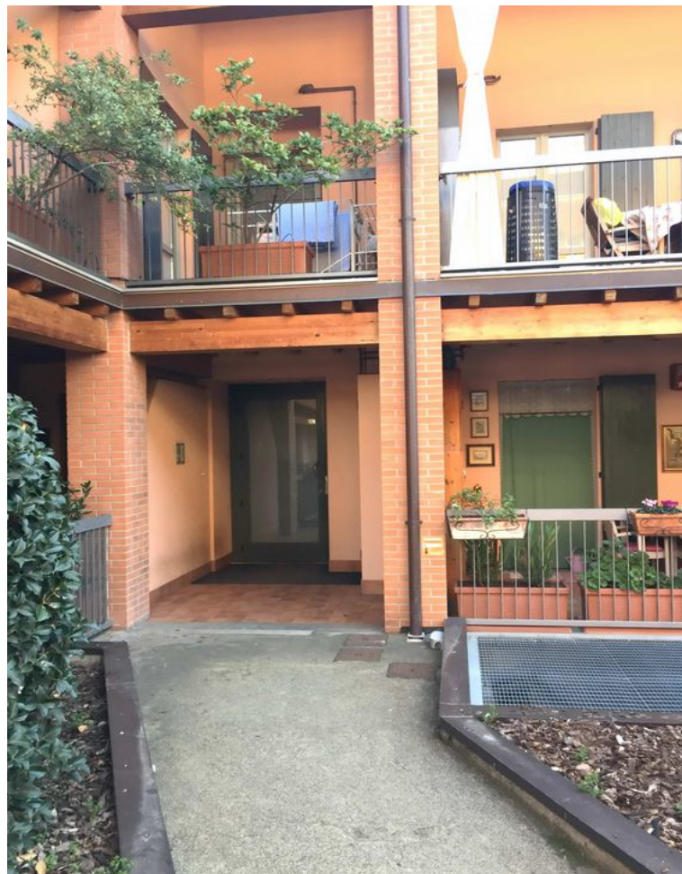
Ingresso dal cortile
