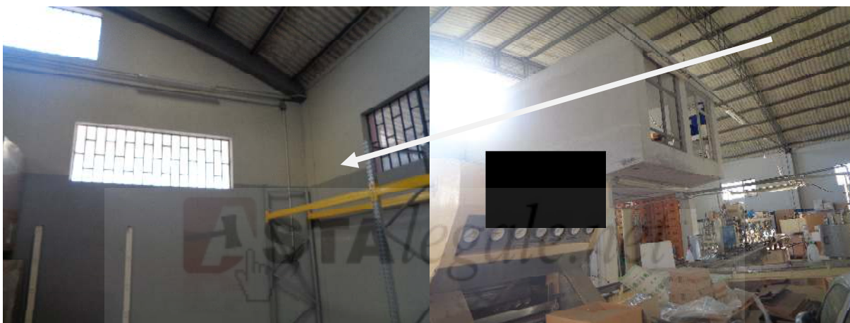
Fig. 8- Foto – Siderno (RC) Foto interne al Capannone
