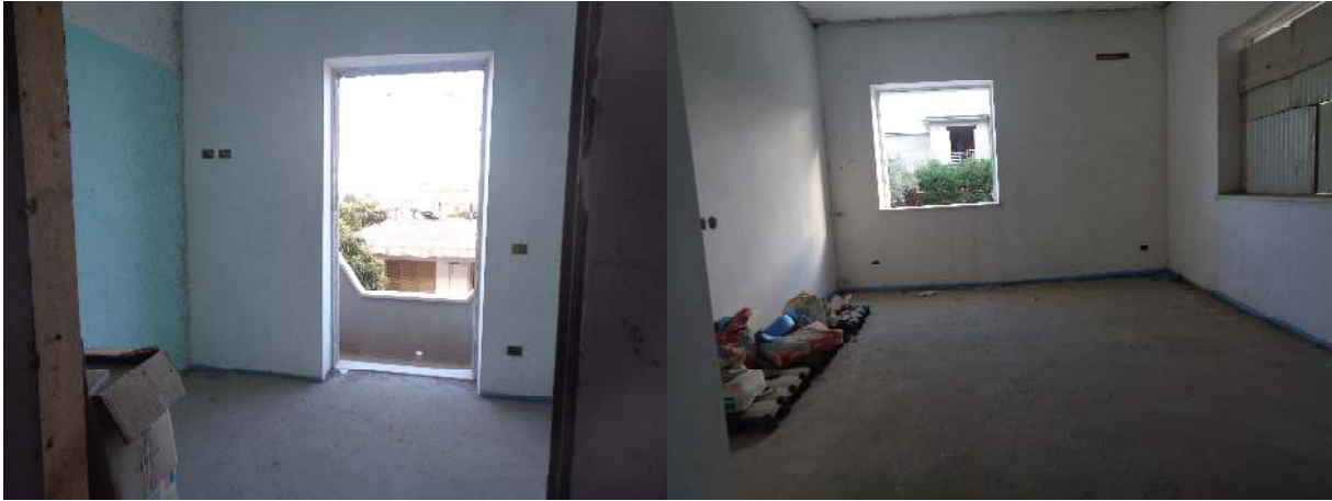
Fig.18 - Foto – Siderno. (RC) Vista interna – piano terra -primo Contrada Grappidaro foglio 16 part. 988-sub 6
