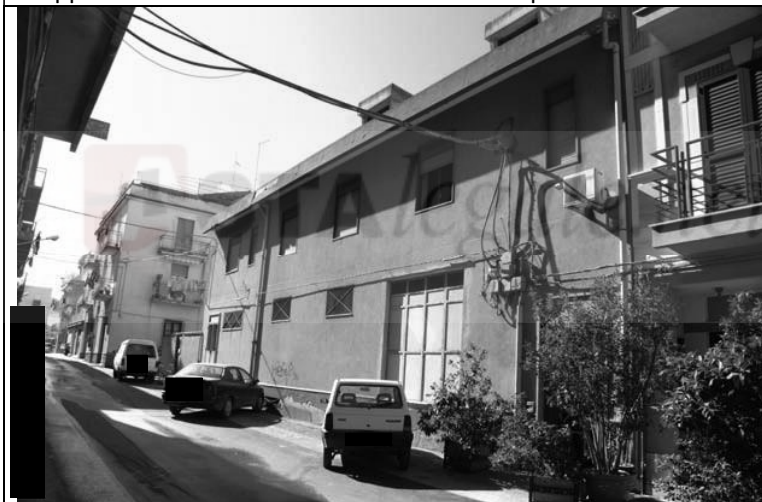
Prospetto su Via XXV Aprile
