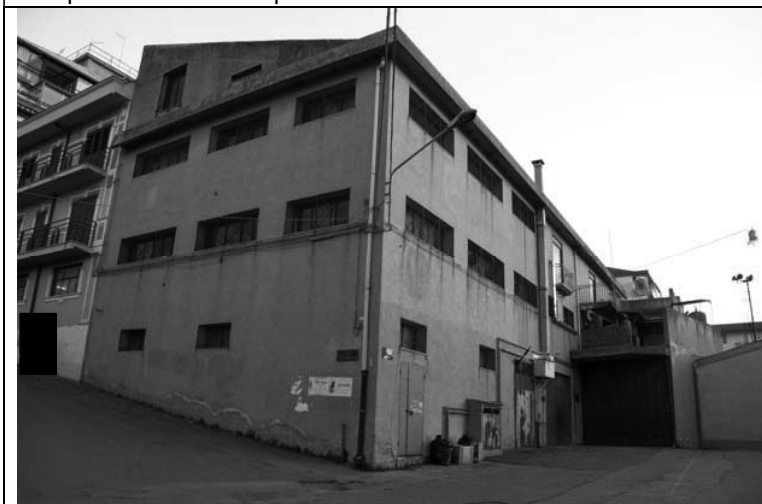
Prospetto su Via Sicilia e su Spiazzale
