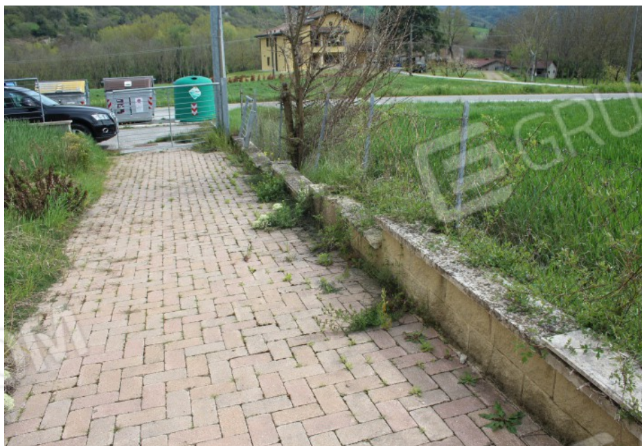
stradello carrabile esclusivo laterale ( vista dal retro verso la via Togliatti )
