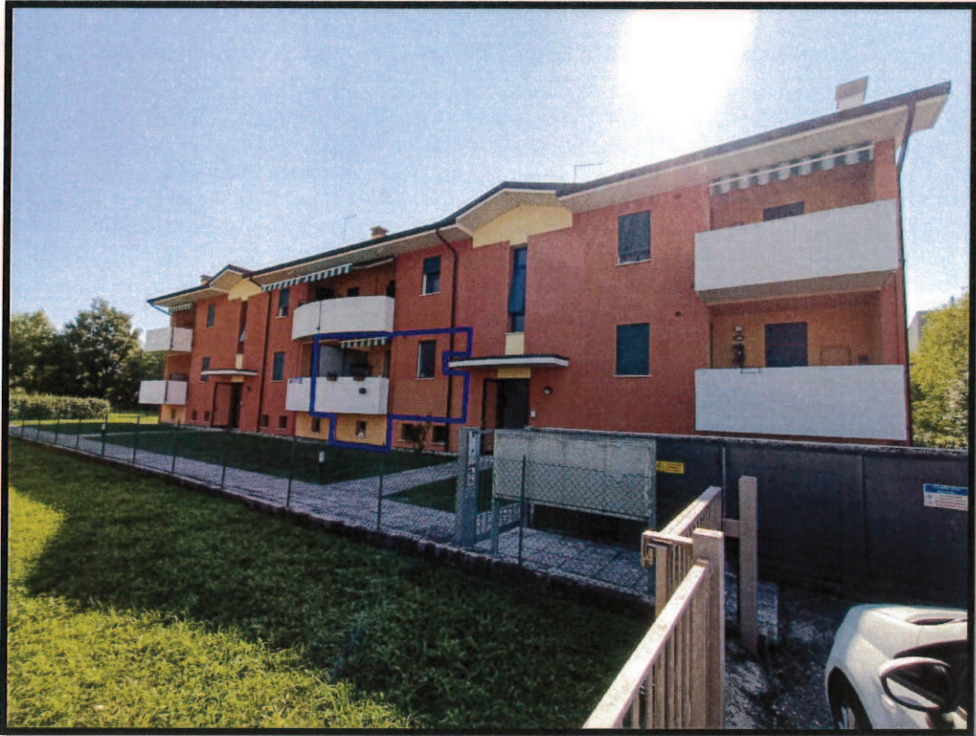
Foto n. 1: Vista appartamento al piano terra ed autorimessa al piano interrato, prospetto Ovest.
