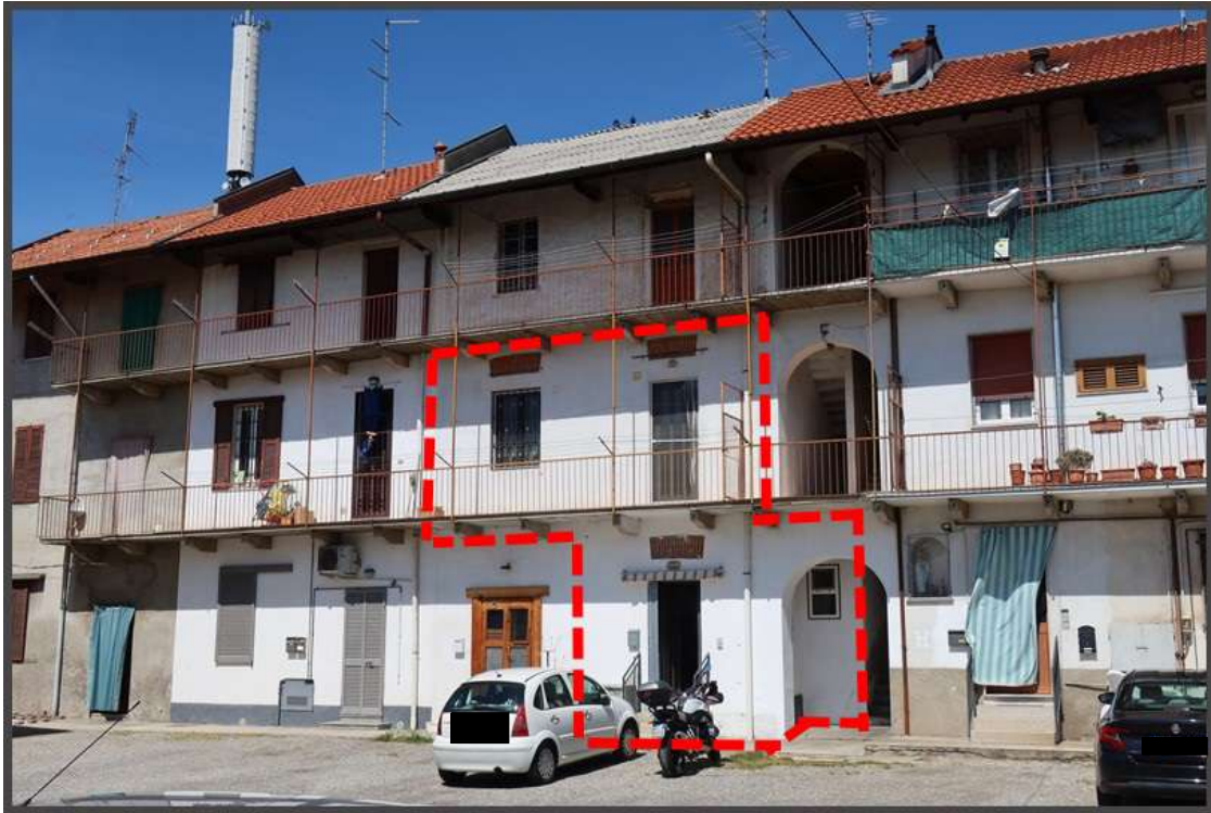
5 – ingresso appartamento PT
