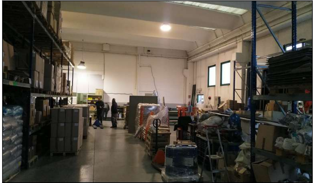
Particolare della copertura in tegole nervate con fasce costituite da pannelli in policarbonato
