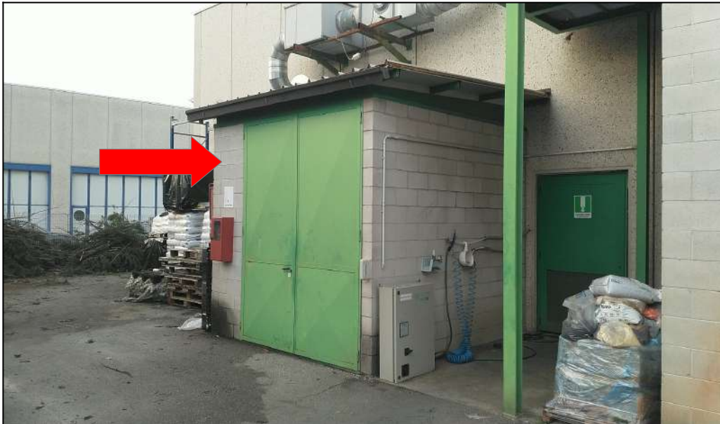
Il locale deposito abusivo presumibilmente sanabile (C)
