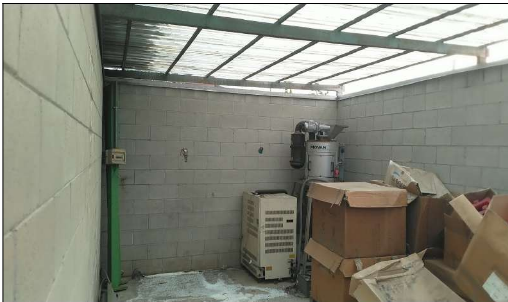
Fotografia dell'interno del piccolo deposito abusivo da demolire
