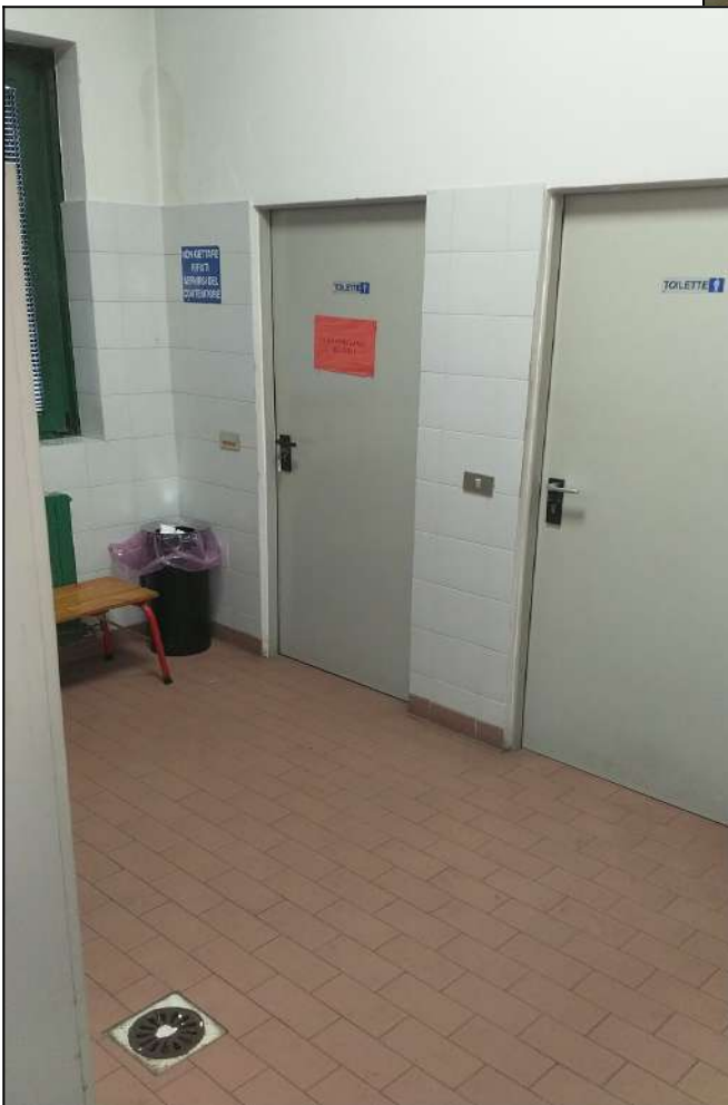
La zona dei servizi igienici al piano terra
