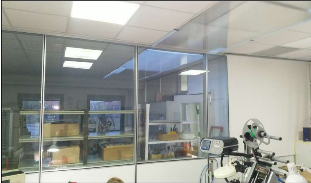
Foto delle pareti "mobili" poste al piano primo zona ufficio/laboratorio (B)
