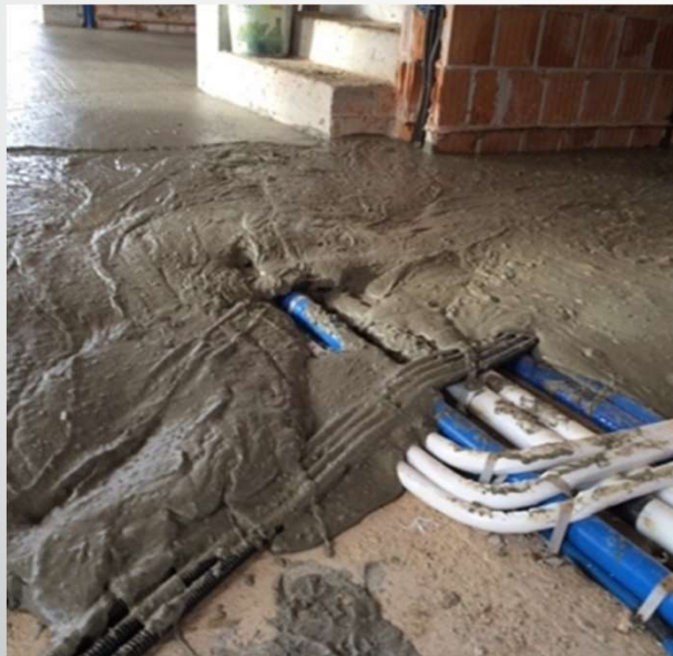
Figura 21 – esecuzione sottofondo alleggerito
