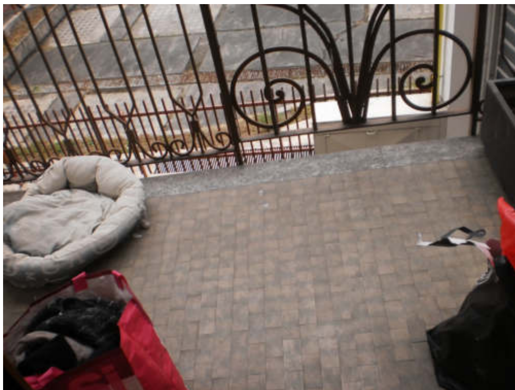
FOTO 40 Vista esterna P1 – Balcone sud
