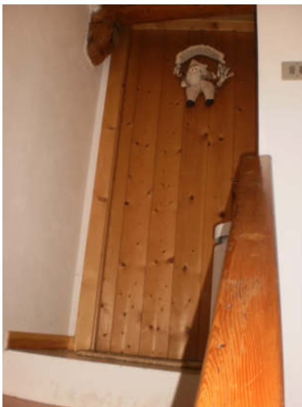
FOTO 64 Vista esterna – Accesso al corridoio comune tra sub.15 e sub.16
