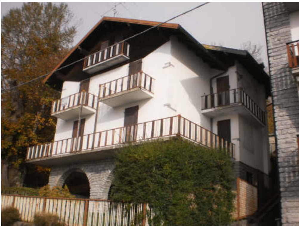
FOTO 52 Vista esterna – Fronte strada per Arvogno e fronte est
