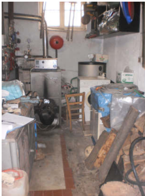
FOTO 62 Vista interna – Autorimessa – vano sud (non riportato nella planimetria catastale)
