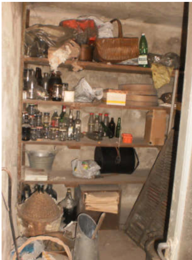
FOTO 49 Vista interna PS1 – Cantina
