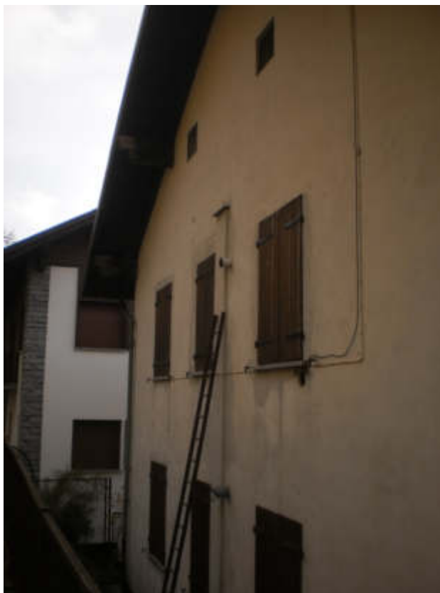
FOTO 55 Vista esterna – Fronte nord
