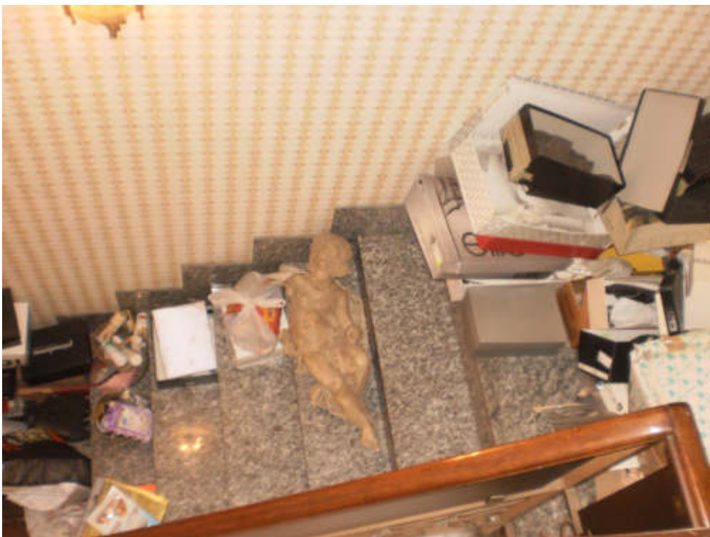
FOTO 46 Vista interna P1 – Scala per accesso a Piano sottotetto
