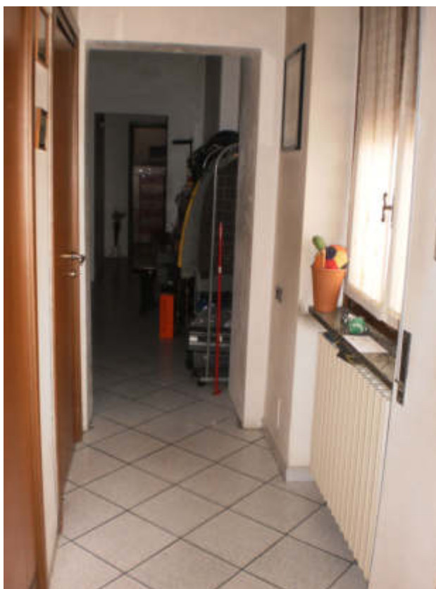
FOTO 28 Vista interna P1 – Disimpegno con accesso dal vano scala
