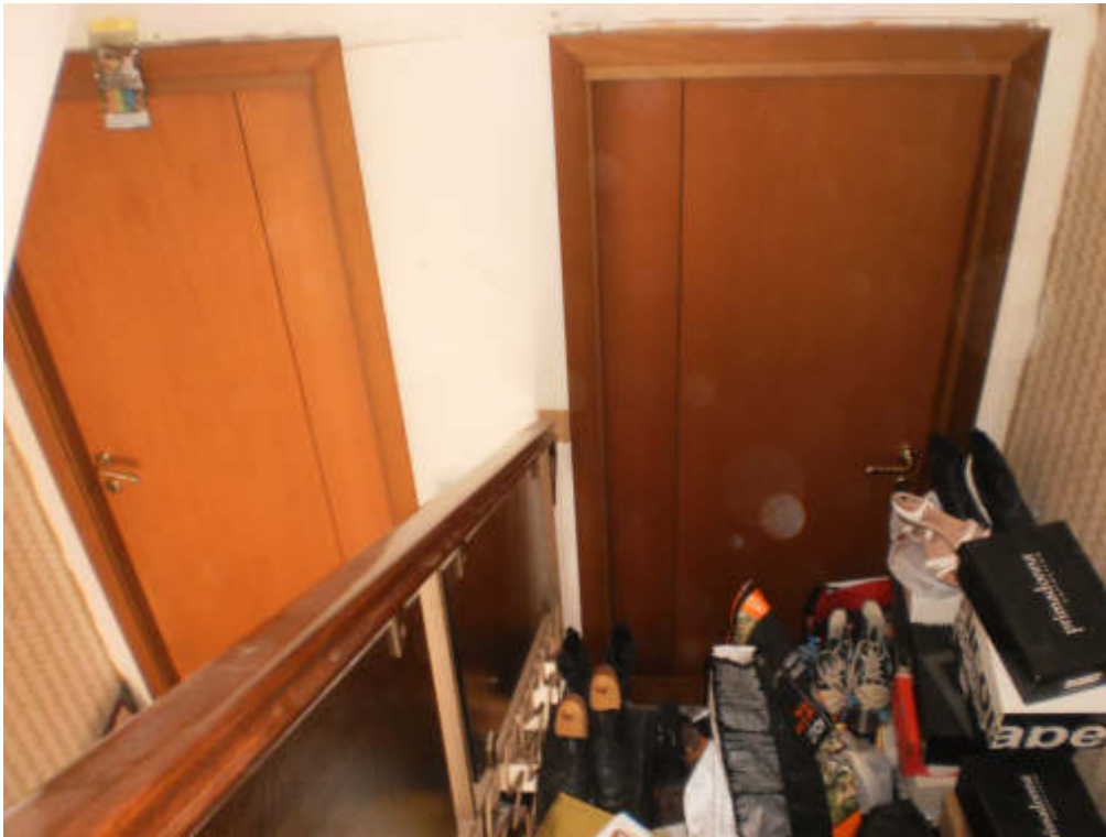
FOTO 45 Vista interna P1 – Scala per accesso a Piano primo e piano sottotetto
