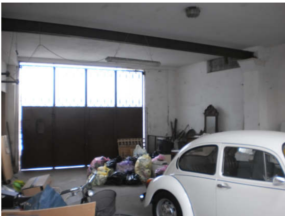
FOTO 17 Vista Interna PT – Ingresso al porticato (lato sud)
