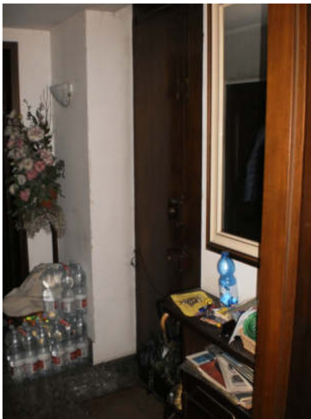
FOTO 9 Vista interna PT – Ingresso pedonale al vano scala comune tra mapp.12249 e 12250 sub.4
