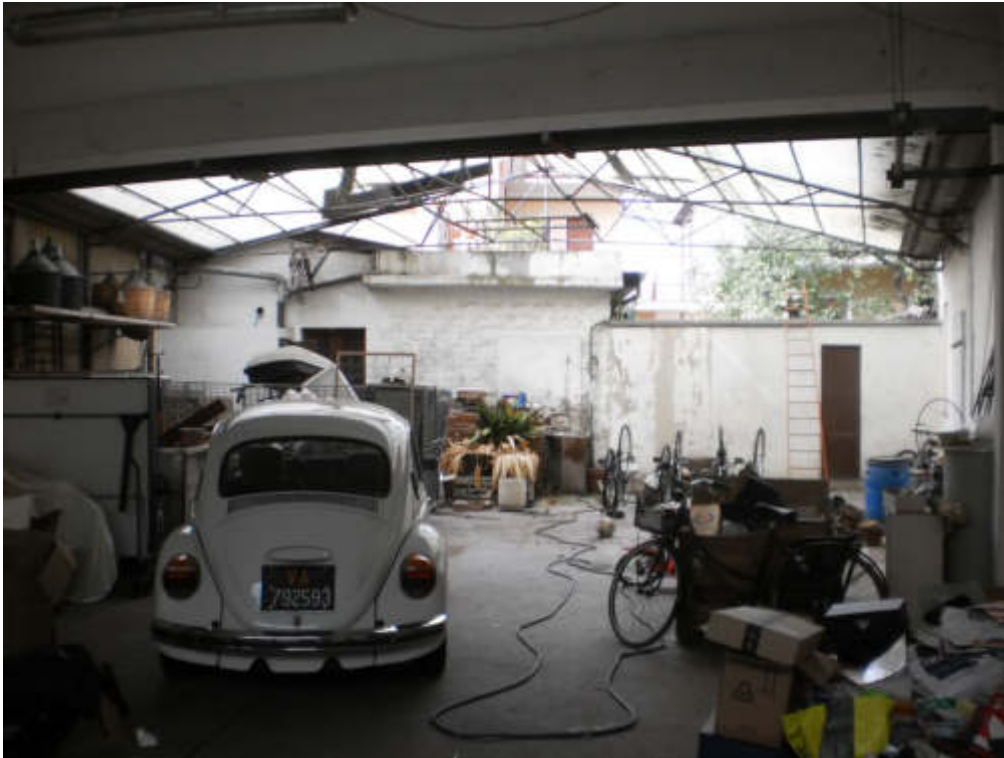
FOTO 19 Vista interna PT – Porticato
