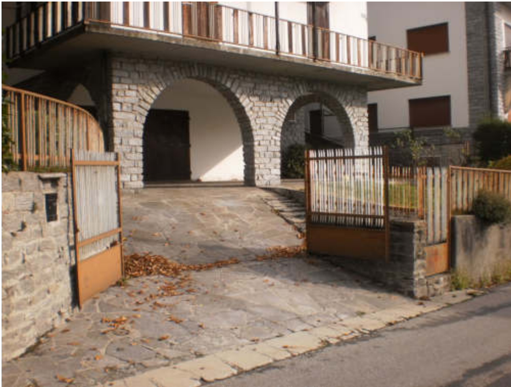
FOTO 53 Vista esterna – Fronte strada per Arvogno – ingresso carraio e pedonale
