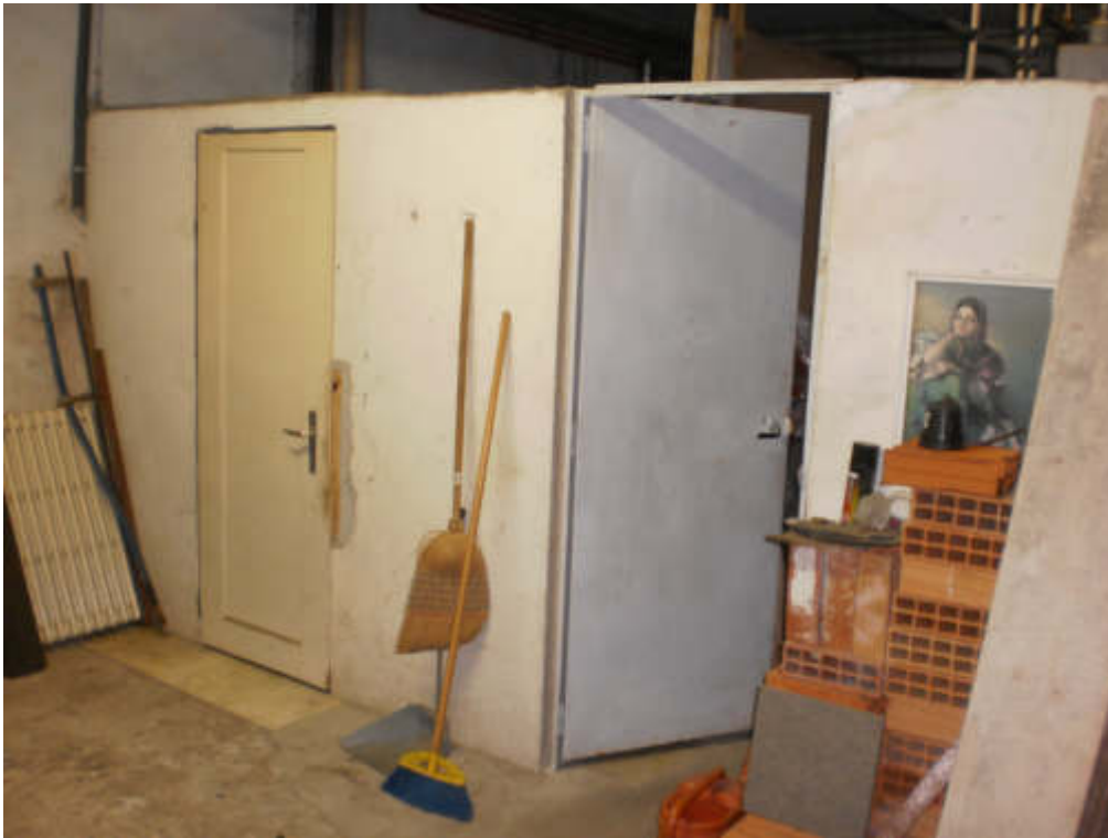
FOTO 61 Vista interna – Autorimessa – divisori interni (non riportati nella planimetria catastale)
