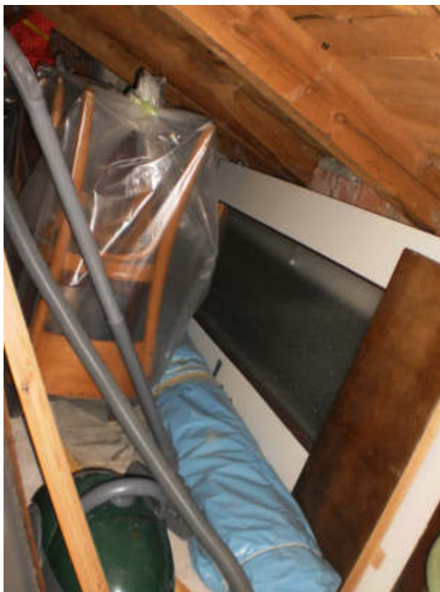
FOTO 71 Vista interna – Locale soffitta (ovest)
