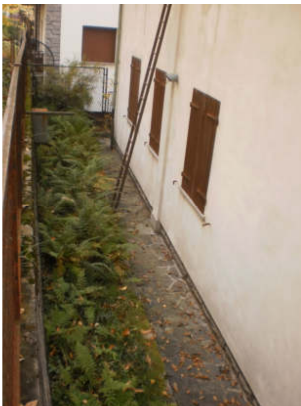
FOTO 56 Vista esterna – Fronte nord
