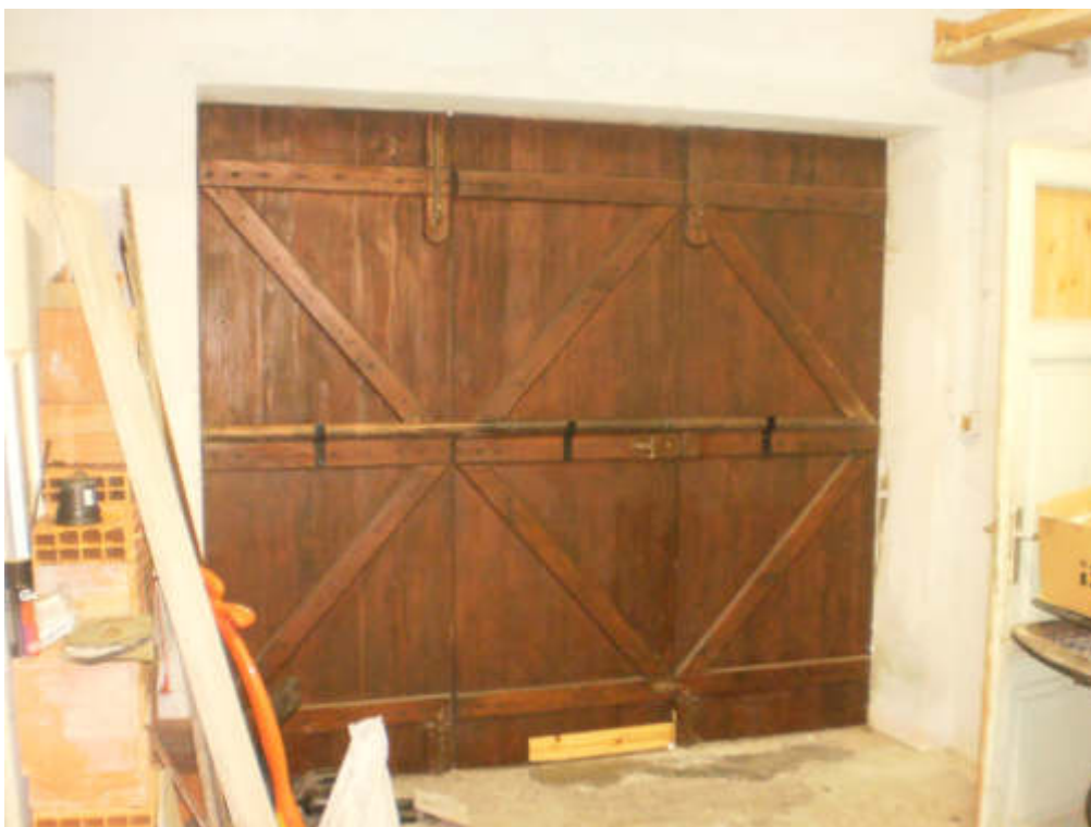
FOTO 60 Vista interna – Autorimessa – accesso da portico
