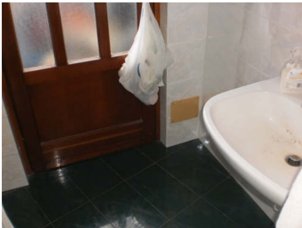
FOTO 36 Vista interna P1 – Bagno nord – uscita verso ripostiglio esterno
