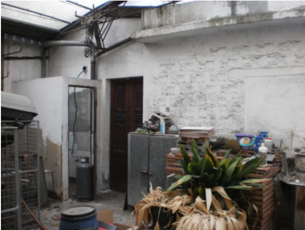
FOTO 21 Vista esterna PT – Ripostiglio e wc a nord con accesso da porticato
