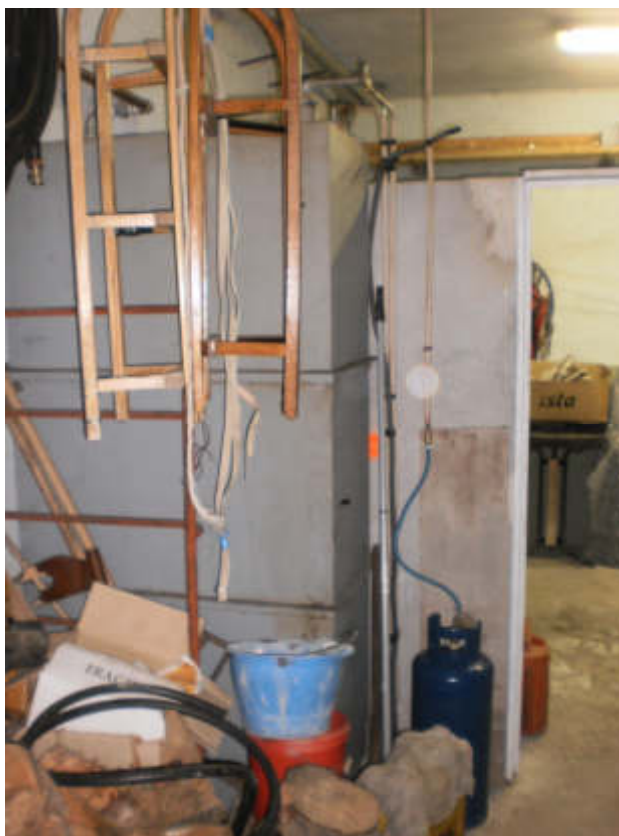
FOTO 63 Vista interna – Autorimessa – accesso al vano sud (non riportato nella planimetria catastale)
