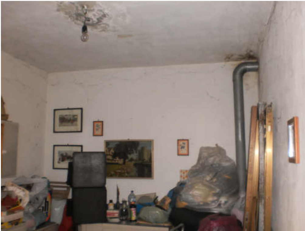
FOTO 23 Vista interna PT – Ripostiglio
