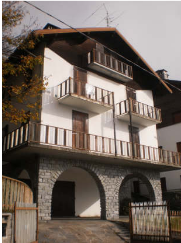
FOTO 51 Vista esterna – Fronte strada per Arvogno (sud)
