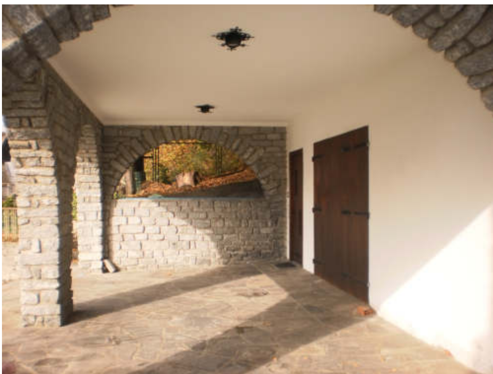
FOTO 58 Vista interna – Portico – accesso al vano scala comune e all'autorimessa
