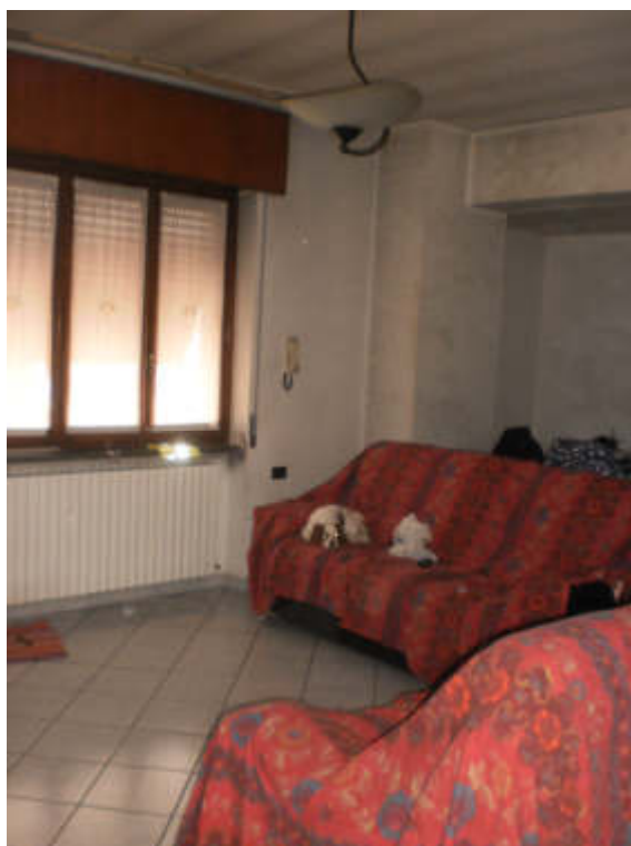
FOTO 30 Vista interna P1 – Locale a sud del vano scala
