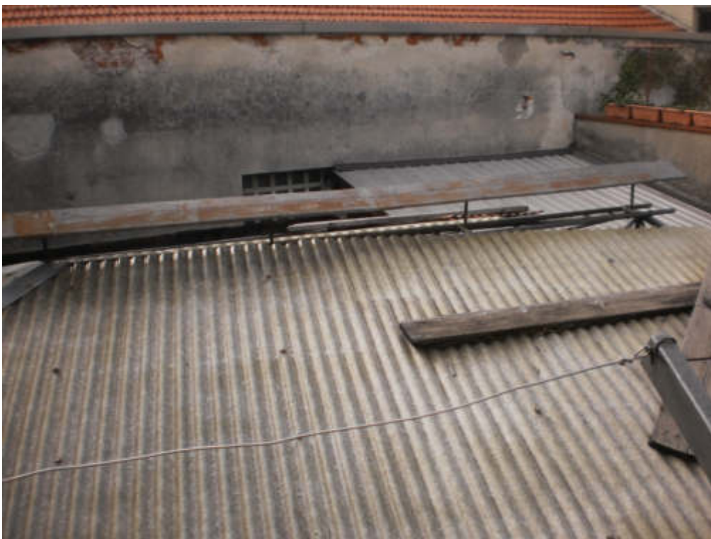
FOTO 20 Vista esterna P1 – Copertura porticato
