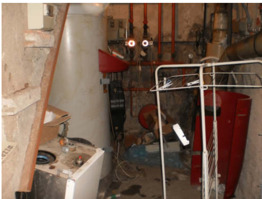
FOTO 48 Vista interna PS1 – Cantina
