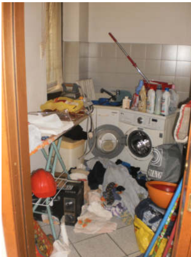
FOTO 27 Vista interna P1 – Bagno nel locale a nord del vano scala – (non riportato nella planimetria catastale)
