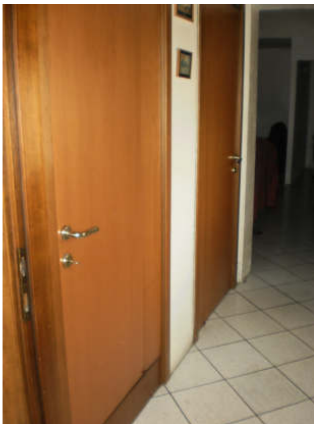
FOTO 29 Vista interna P1 – Ingresso da vano scala e accesso al vano scala per salita a sottotetto
