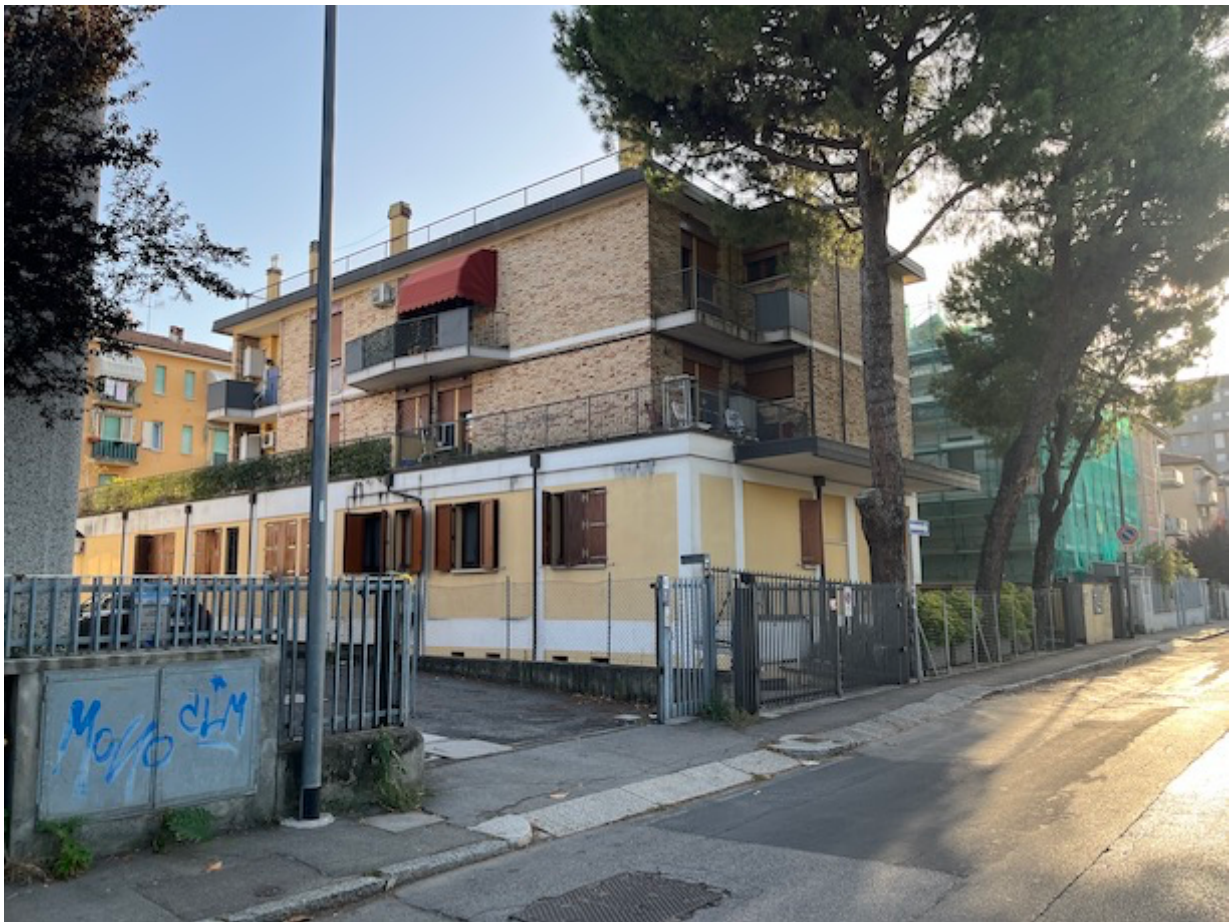
Lo stabile di cui l'immobile è parte – prospetto dalla via principale
