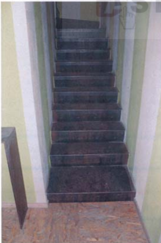
Foto 97: Ingresso e scala di accesso al piano superiore
