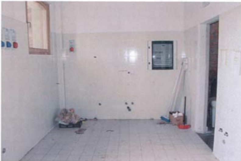
Foto 90: Locale di servizio - 1° piano
