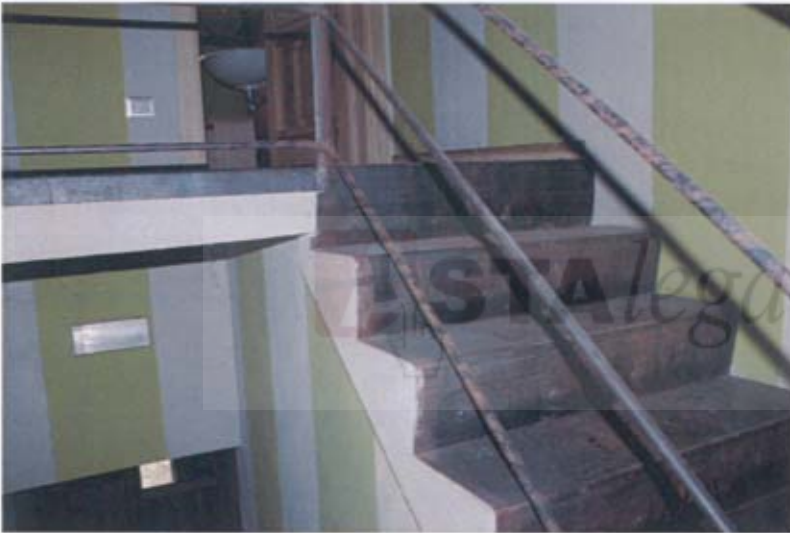
Foto 106: Part. scala interna
