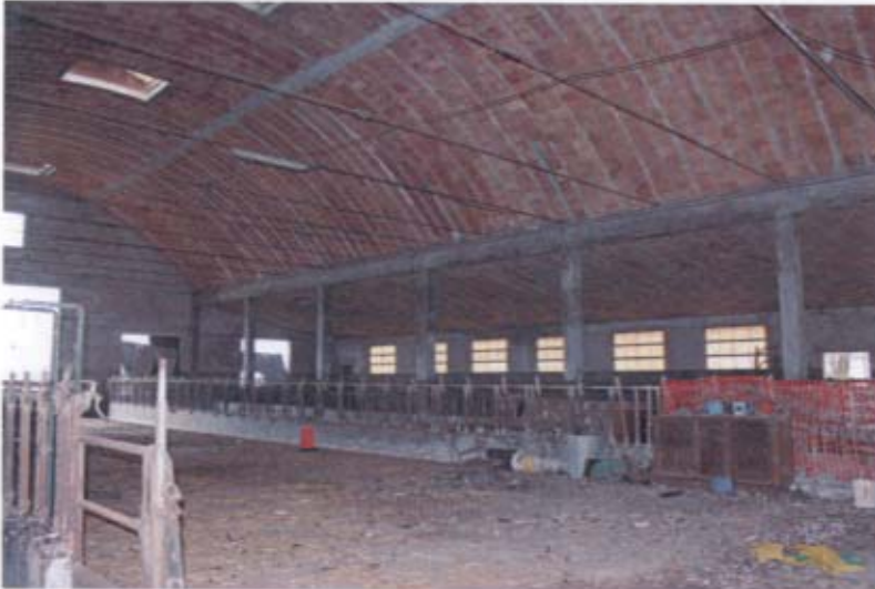
Foto 74: Fabbricati ex stalla – Mapp. 58/503
