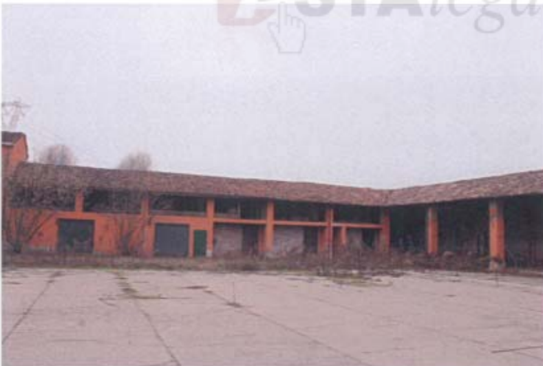
Foto 64: Fabbricati rurali – Fronte Nord
