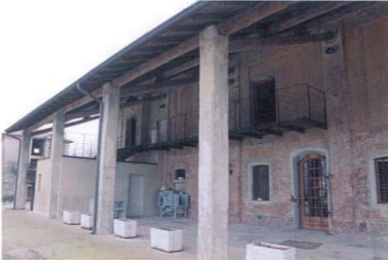
Foto 84: Porticato fronte Nord
