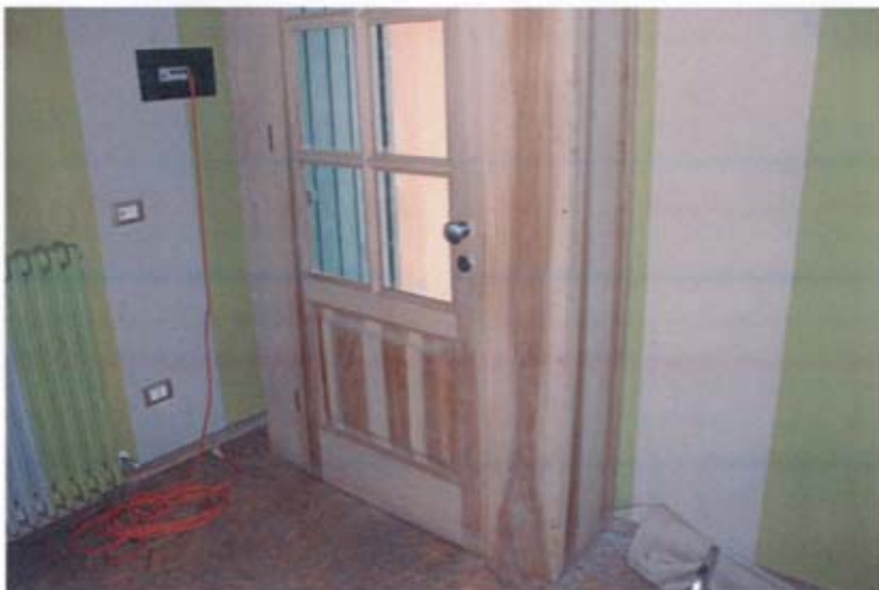
Foto 100: Part. serramento id'ingresso
