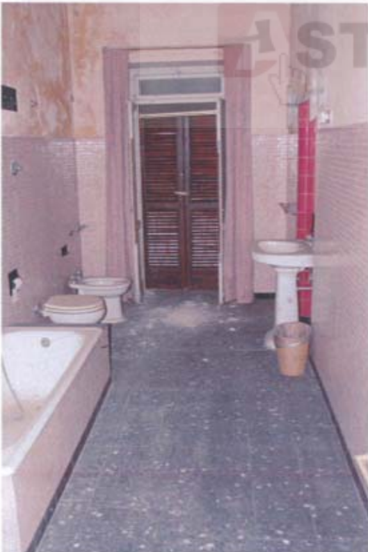
Foto 18: Bagno primo piano
