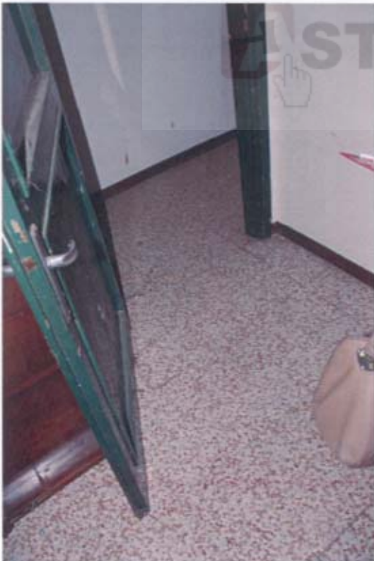
Foto 45: Part. pavimentazione stanze da letto
