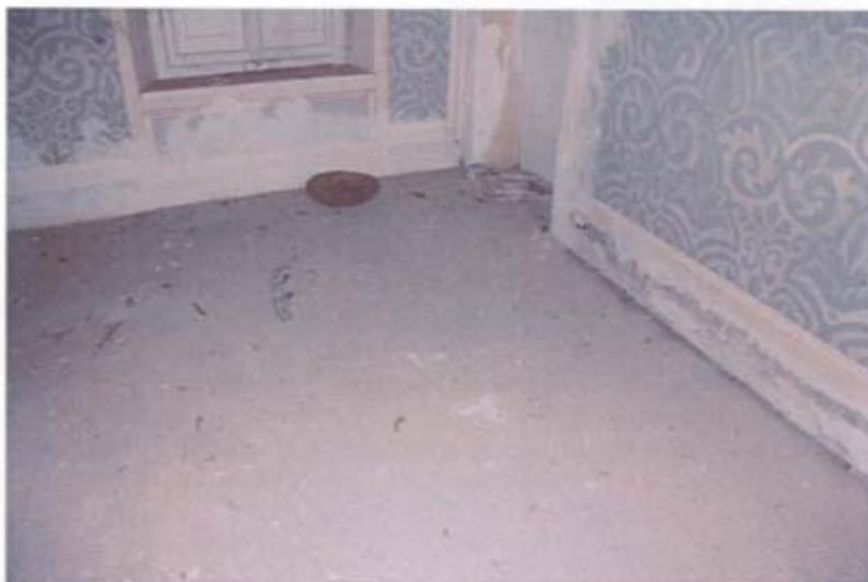
Foto 22: Part. nuovo solaio interpiano (letto 2)
