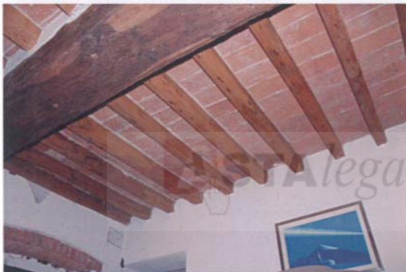
Foto 39: Part. solaio d'interpiano soggiorno
