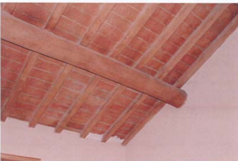
Foto 62: Part. copertura camera da letto 1
