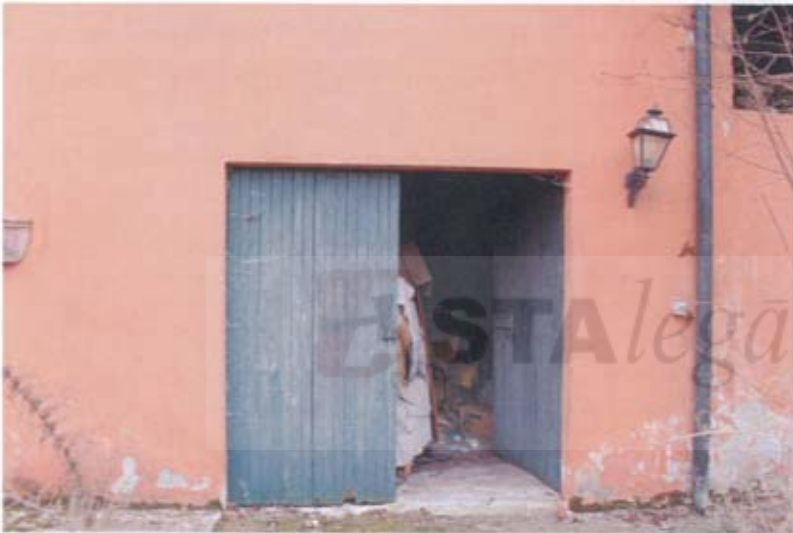
Foto 47: Porta ingresso cantina- fronte Nord
