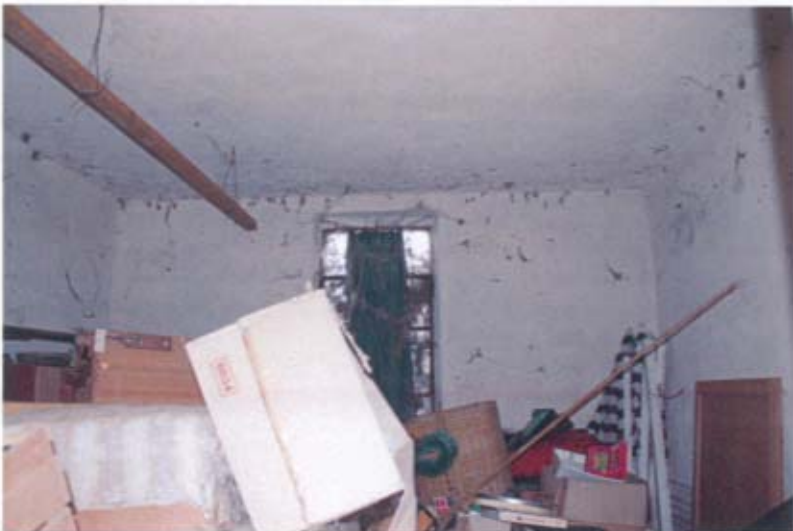
Foto 48: Interno locale cantina
