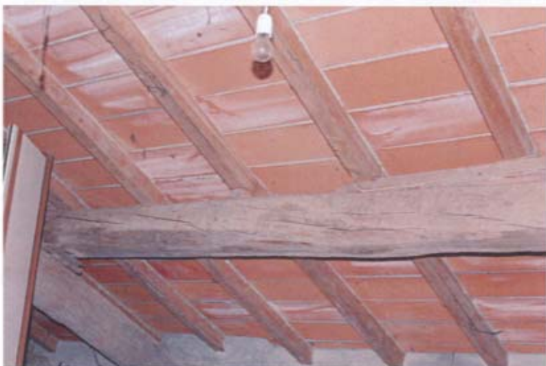
Foto 24: Part. copertura locale soffitta
