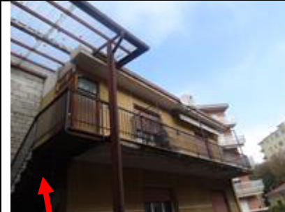
Corpo scale a servizio del sub 10 e sub 11 attualmente insistente su altra proprietà non oggetto di pignoramento (sub 7)
