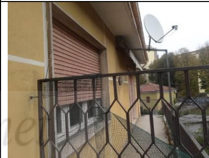
Sub 11, Vista interna balcone lato sud
