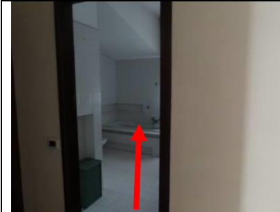
Sub 11, bagno attualmente in parte insistente su altra proprietà non oggetto di pignoramento (sub 7)
