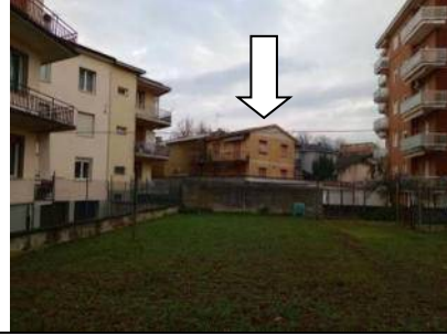
Vista da Via Calda
