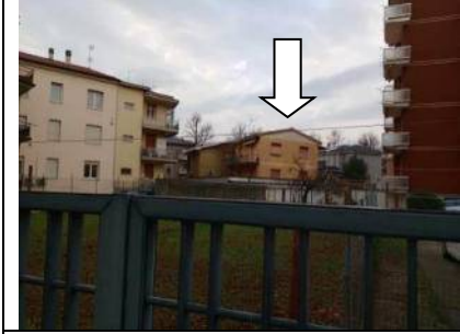
Vista da Via Calda
