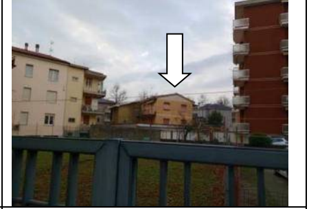
Vista da Via Calda
