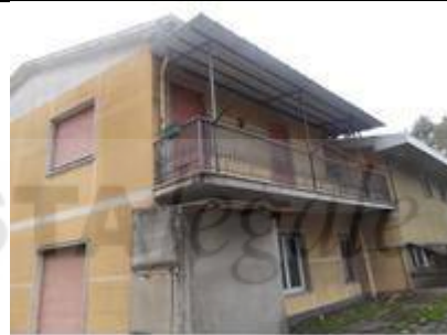
Prospetto nord est vista da sub 13 (BCNC ai soli sub 10 e sub 11)
