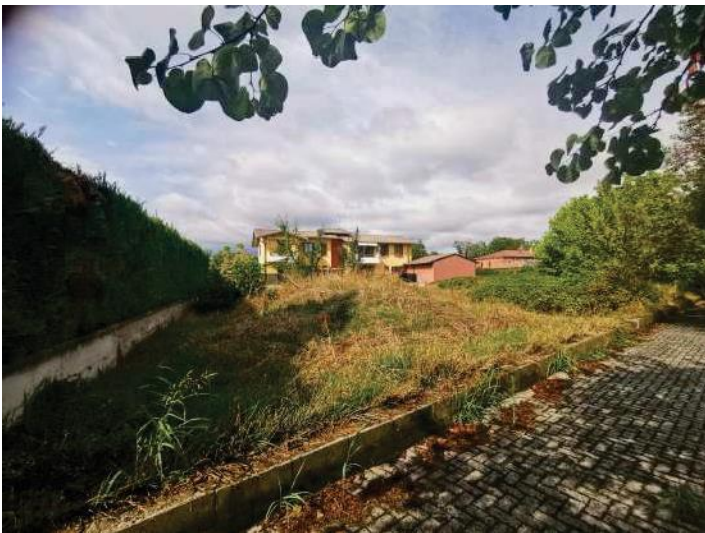
Foto 20) Part. cordolo di delimitazione area lato SUD
