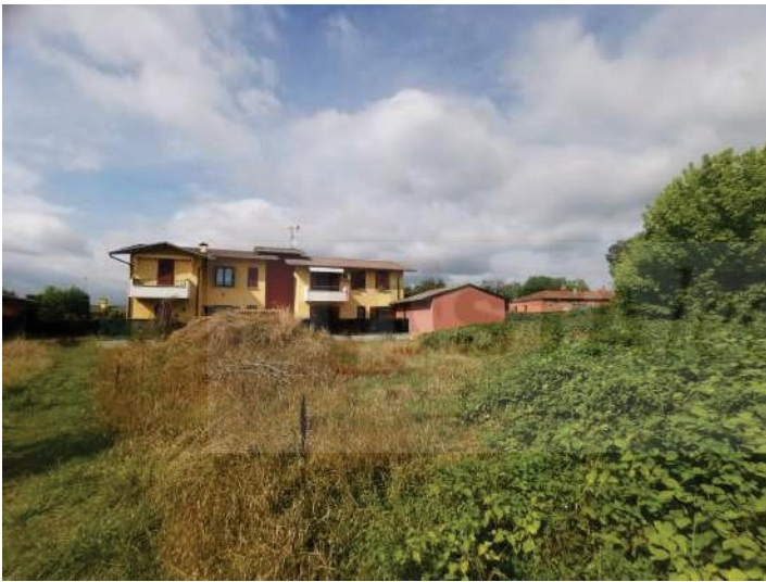
Foto 22) Vista area edificabile da S/E
