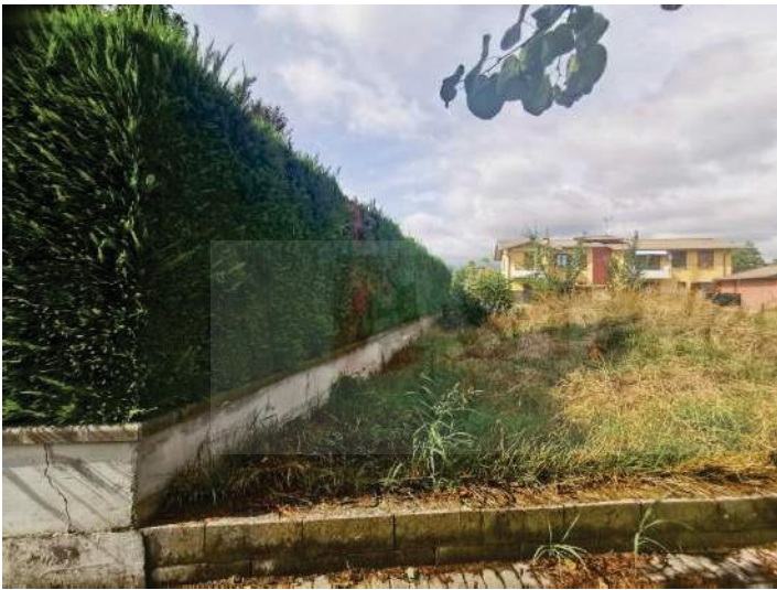
Foto 19) Vista recinzione esistente lato ovest
