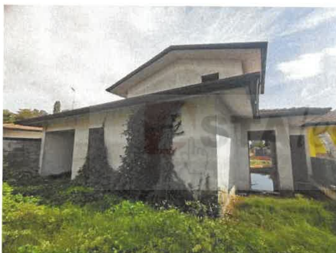
Foto 02) Fronte nord – prospetto posteriore
