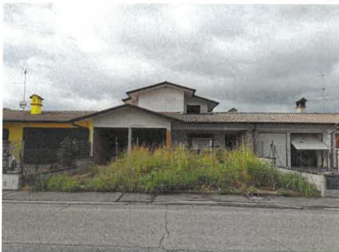
Foto 01) Fronte sud verso la via Grassi – pr. anteriore
