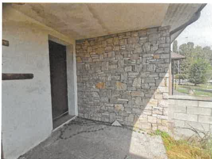
Foto 07) Part. rivestimento in pietra porticato anteriore
