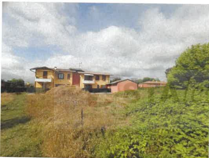
Foto 22) Vista area edificabile da S/E
