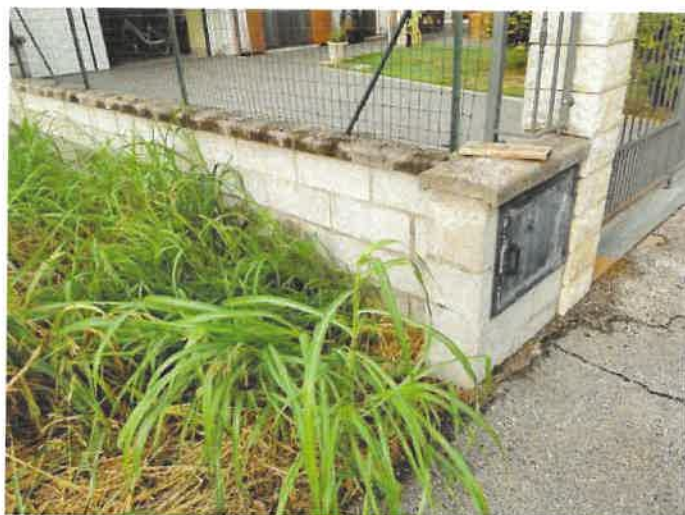
Foto 03) part. recinzione verso la via Grassi
