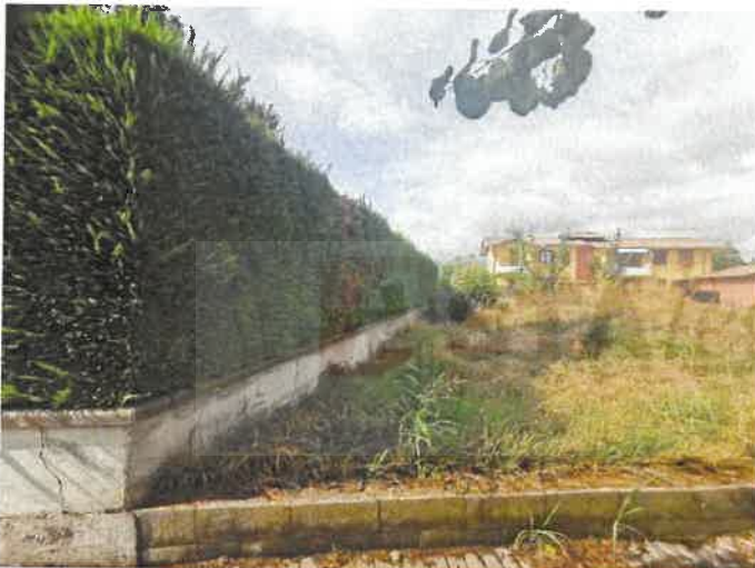
Foto 19) Vista recinzione esistente lato ovest
