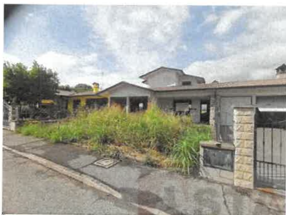
Lotto 01 – Unità in corso di costruzione
