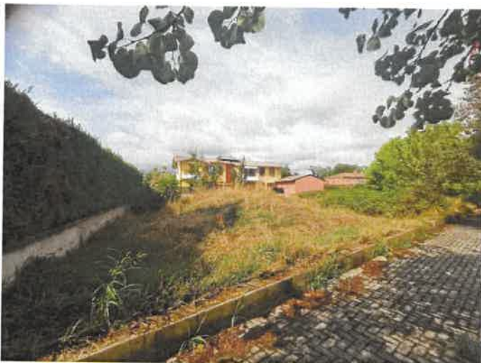
Foto 20) Part. cordolo di delimitazione area lato SUD
