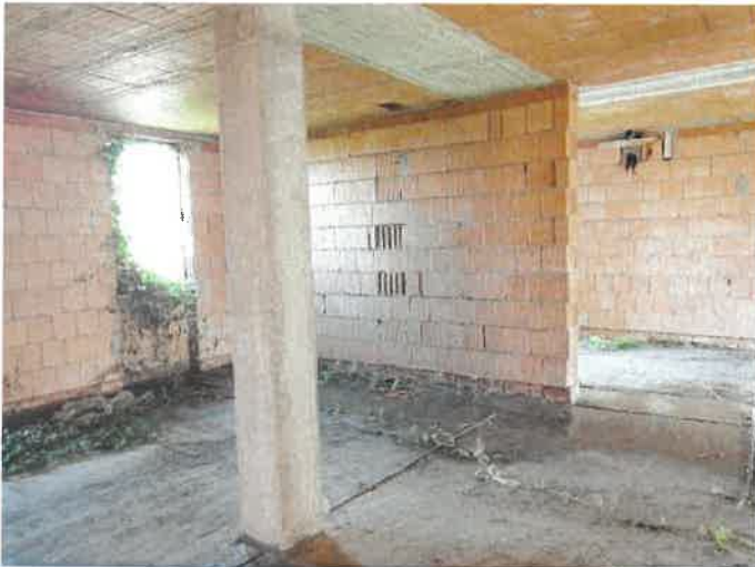
Foto 10) Part. interno piano terra
