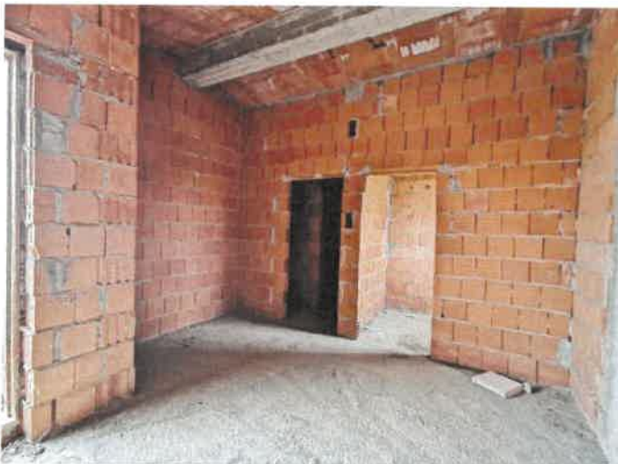
Foto 12) Part. interno primo piano
