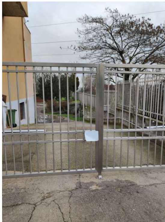
Particolare cancello carraio d'accesso alla rampa
