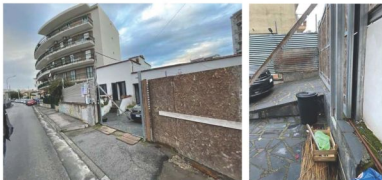
Foto 4, 5 - Ingresso dalla strada e dettaglio rampa interna
