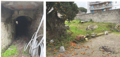
Foto 35, 36 - Dettaglio accesso al piano interrato ed al fondo esteso a nord
