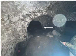
Foto 28 – A sx l'unico accesso al vano non censito verso est, posto in corrispondenza verticale del vano 3, appartenente alla ex p.lla 112/1
