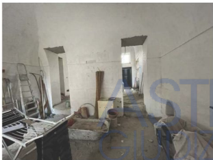
Foto 17 - Vano 4 a sud, controcampo verso il vano 3
