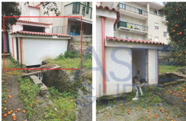
Foto 33, 34 – Dettaglio del volume servizi (w.c. 1) annesso a nord, con accesso esterno al ripostiglio ed al sottostante locale cantinato
