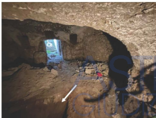
Foto 23 - Primo vano comunicante a sud, in corrispondenza dei vani ex p.lla 111/ Si notano gli scavi per i saggi alle strutture
