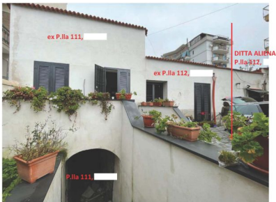
Foto 1 - Prospetto principale sud su corte comune alla p.lla 114
