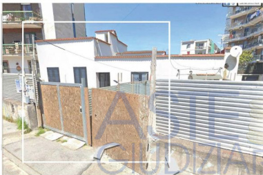
Fronte principale proiettato a sud con accesso diretto dalla strada. L'unità abitativa si colloca al piano rialzato di fabbrica (Cfr. riquadro)
