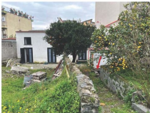
Foto 32 – Fronte secondario del fabbricato esposto a nord. La frecci indica l'accesso al cantinato
