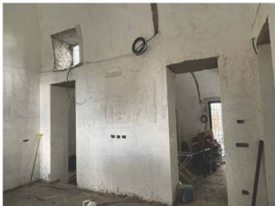
Foto 16 - Frontale verso il vano 4 a sud dal vano 3, ex p.lla 112/
