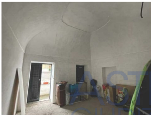
Foto 6 - Ingresso dal ballatoio su vano 1 a sud, ex p.lla 111/I
