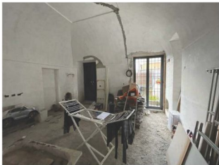
Foto 18 - Vano 4 a sud, ex p.lla 112/
