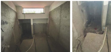
Foto 9,10 – Volume servizi aggiunto a N-0 (wc 1)
