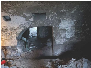
Foto 24 – Controcampo verso il vano successivo a nord. In fondo l'altro accesso dal giardino
