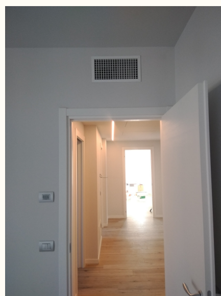
Bocchetta di immissione VMC (predisposta per raffrescamento)
