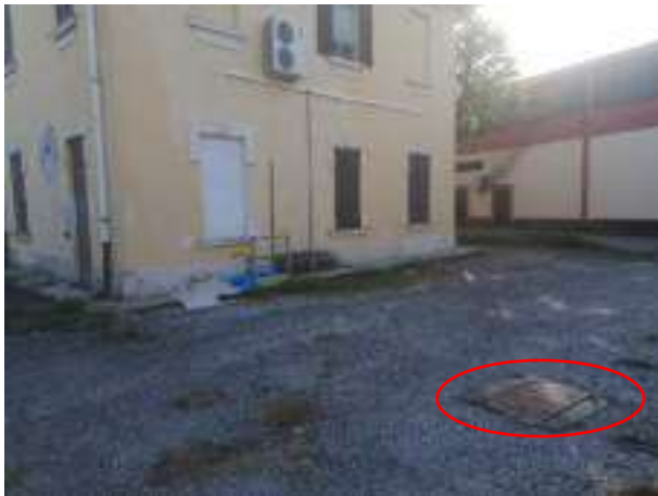
Possibile passo d'uomo serbatoio uffici
