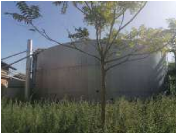
Deposito acque industriali
