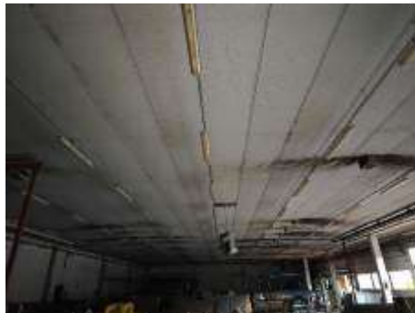
Controsoffitti con pannelli contenenti FAV
