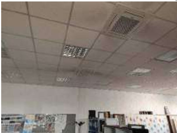
Controsoffitti con pannelli contenenti FAV
