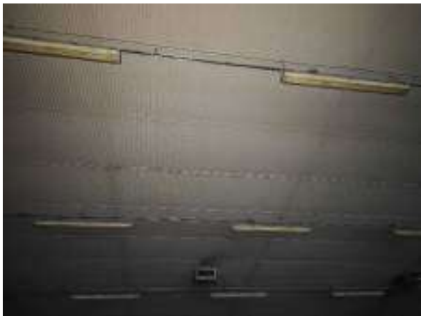
Controsoffitti con pannelli contenenti FAV
