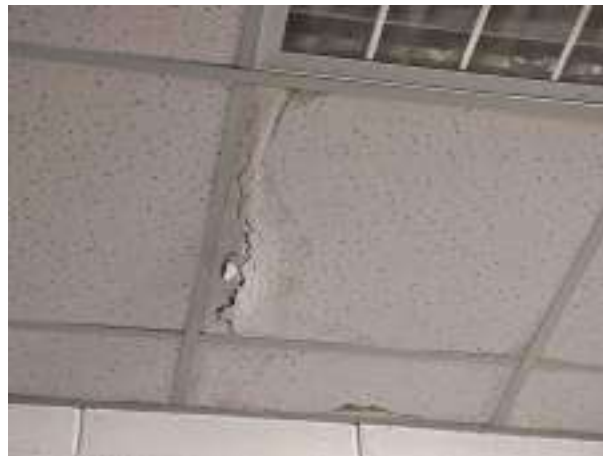
Controsoffitti con pannelli contenenti FAV
