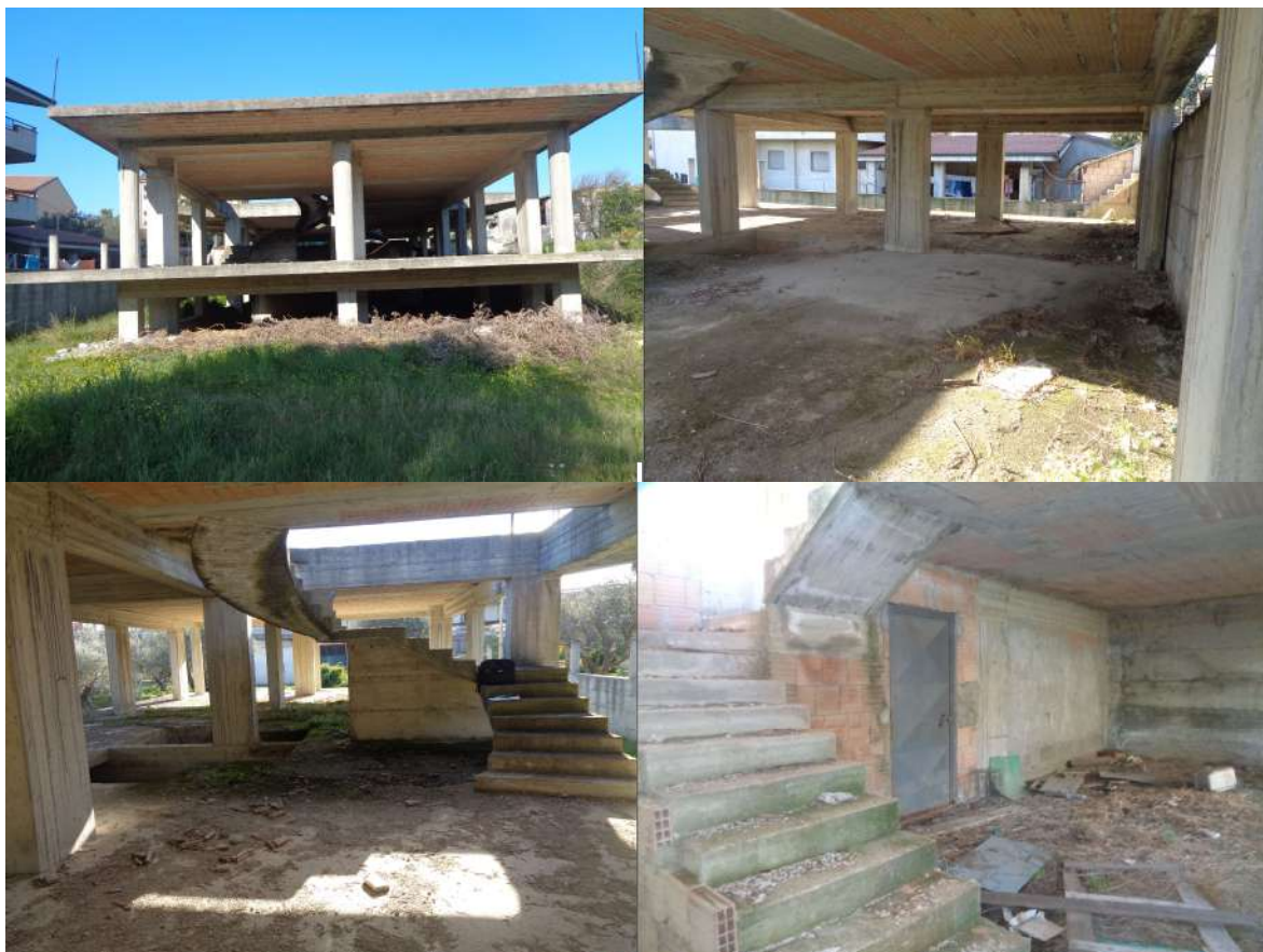
Fig. 4. Foto del fabbricato in corso di costruzione dove si trovano gli immobili oggetto di stima - foglio 34 - particella 1323-1805
