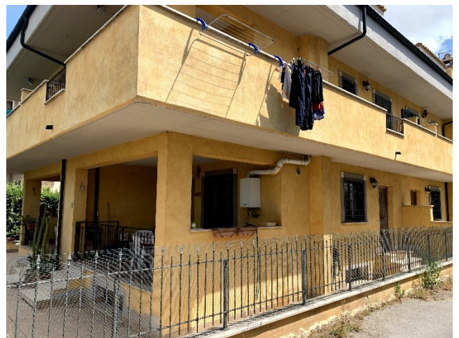
Vista Esterna Piano Terra
