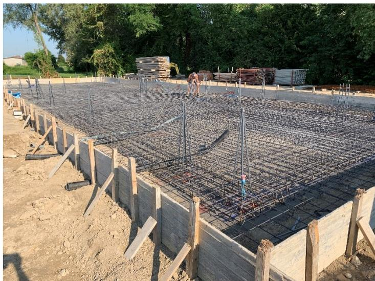
Strutture quali travi, pilastri, solerte, cordoli, cappa solai, architravi, eventuali strutture sottili e le scale interne previste dal progetto architettonico, saranno realizzate in calcestruzzo armato e gettato in opera.
