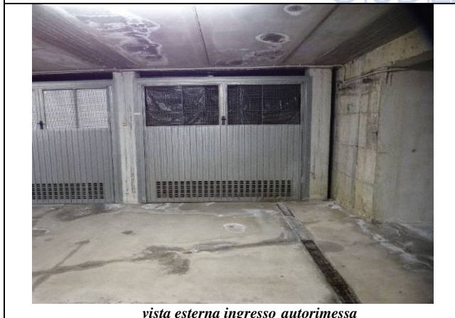
vista esterna ingresso autorimessa
