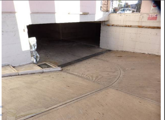
rampa di accesso al piano seminterrato
