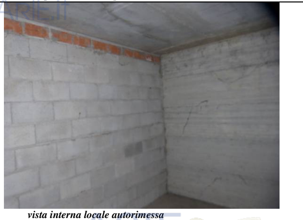
vista interna locale autorimessa
