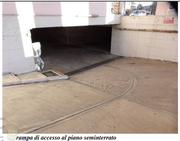
rampa di accesso al piano seminterrato
