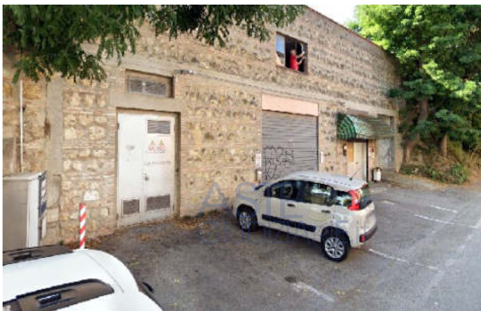
Fronte su via Giovanni Bovio n.15
