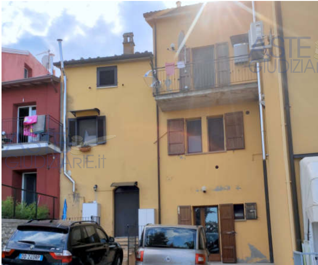
Accesso al piano interrato
