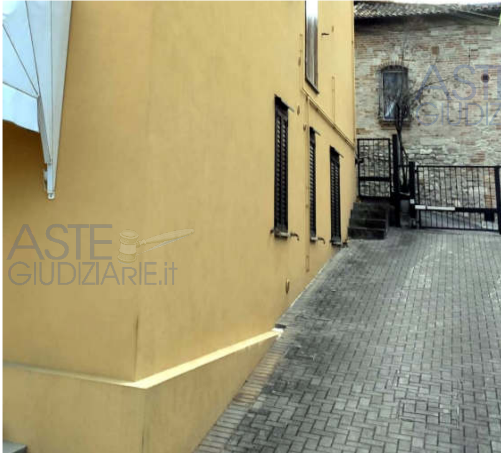
Stradello comunicante con la via Dei Santi
