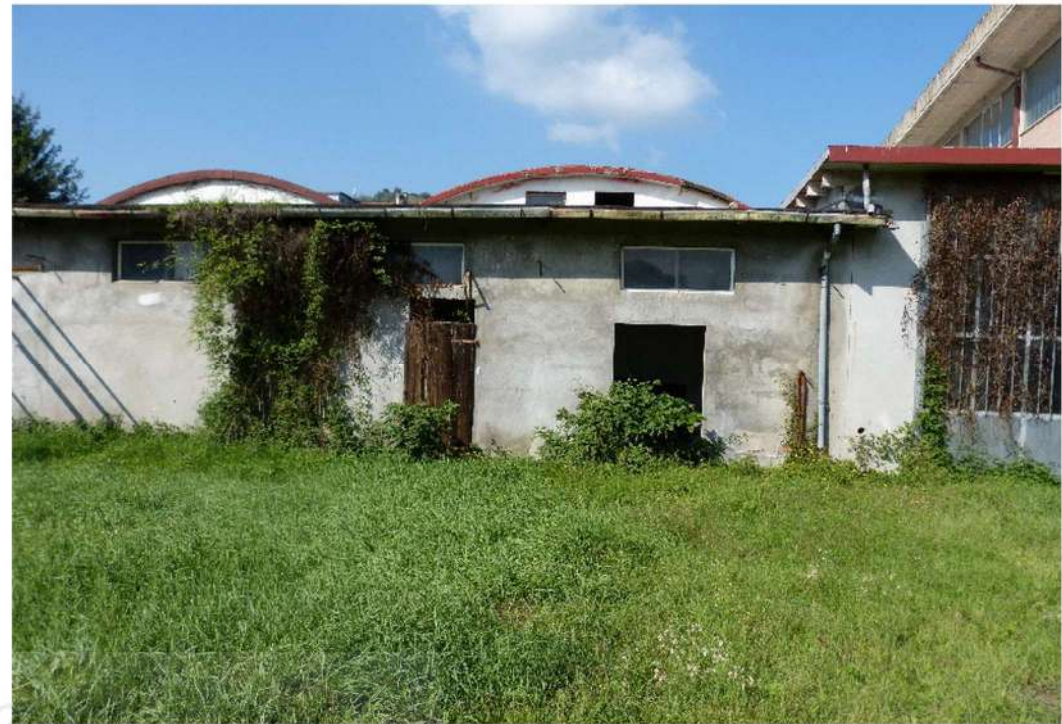
vista esterna lato sud ovest - locale "laboratorio"
