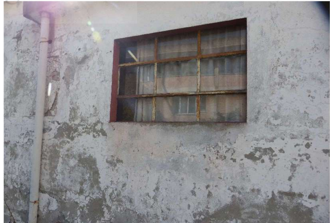
particolare parete esterna e infisso
