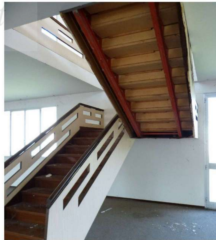
scala di collegamento
