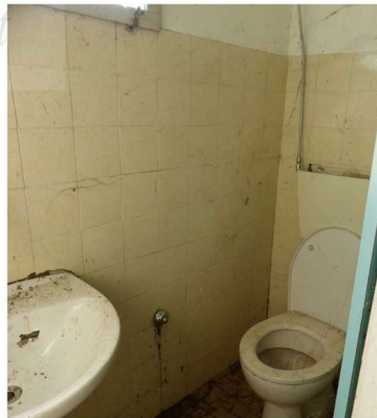
bagno-wc - corpo principale
