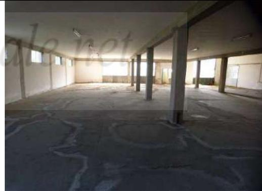
Piano seminterrato, si notano le tracce di risalita capillare d'acqua dal sottofondo
