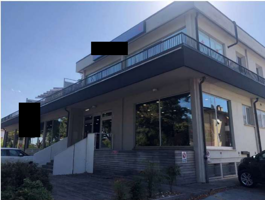
Foto 1 - Prospetto Nord-Est – Viale Roma
