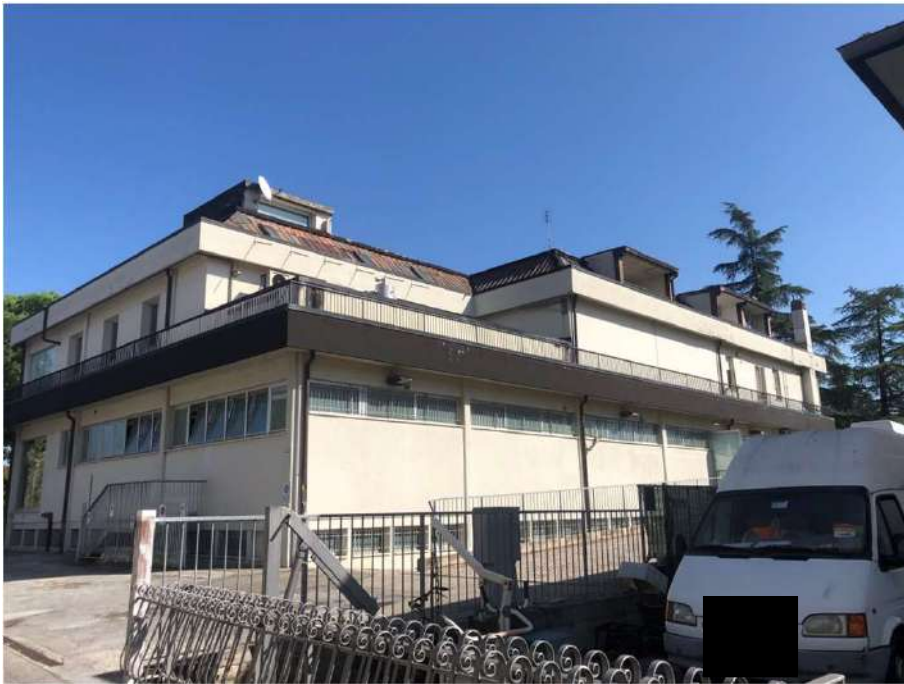
Foto 3 - Prospetto Sud-Ovest – Viale Roma
