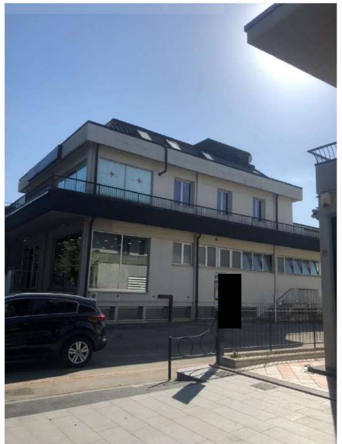
Foto 2 - Prospetto Nord-Ovest – Viale Roma
