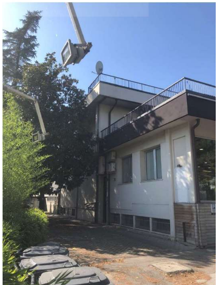
Foto 4 - Prospetto Sud-Ovest – Viale Roma
