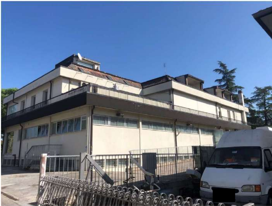
Foto 3 - Prospetto Sud-Ovest – Viale Roma
