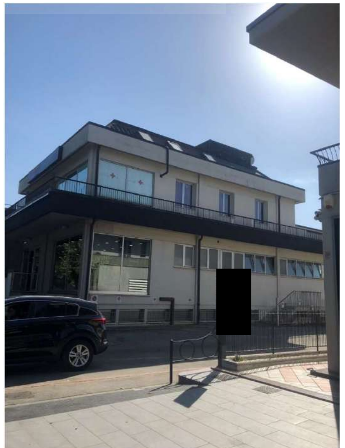
Foto 2 - Prospetto Nord-Ovest – Viale Roma
