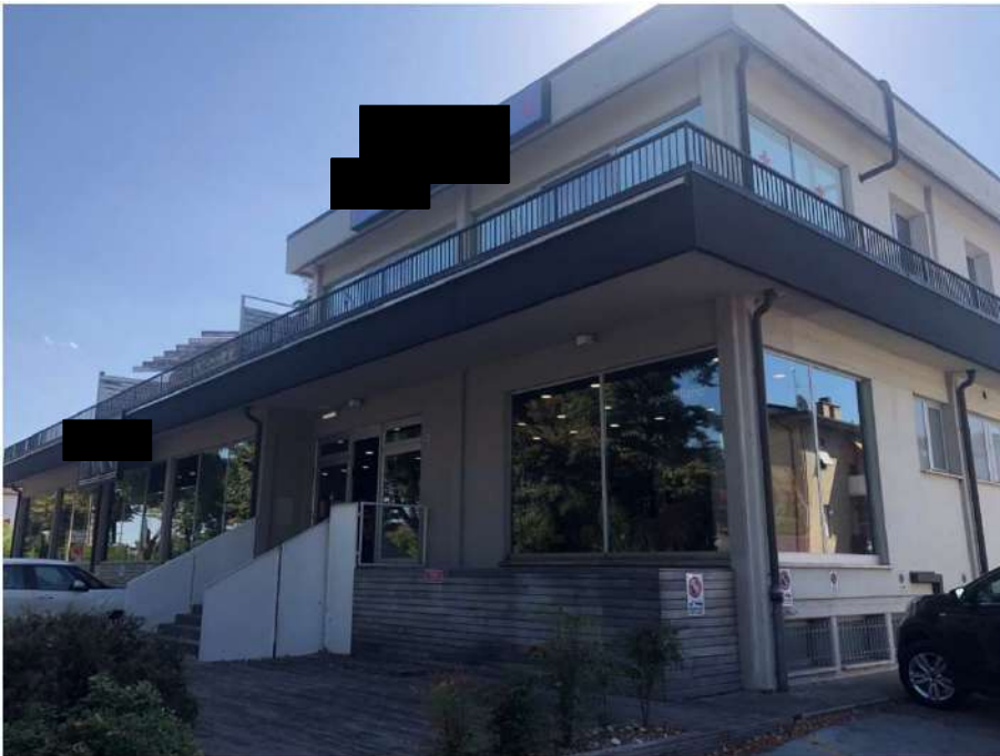
Foto 1 - Prospetto Nord-Est – Viale Roma
