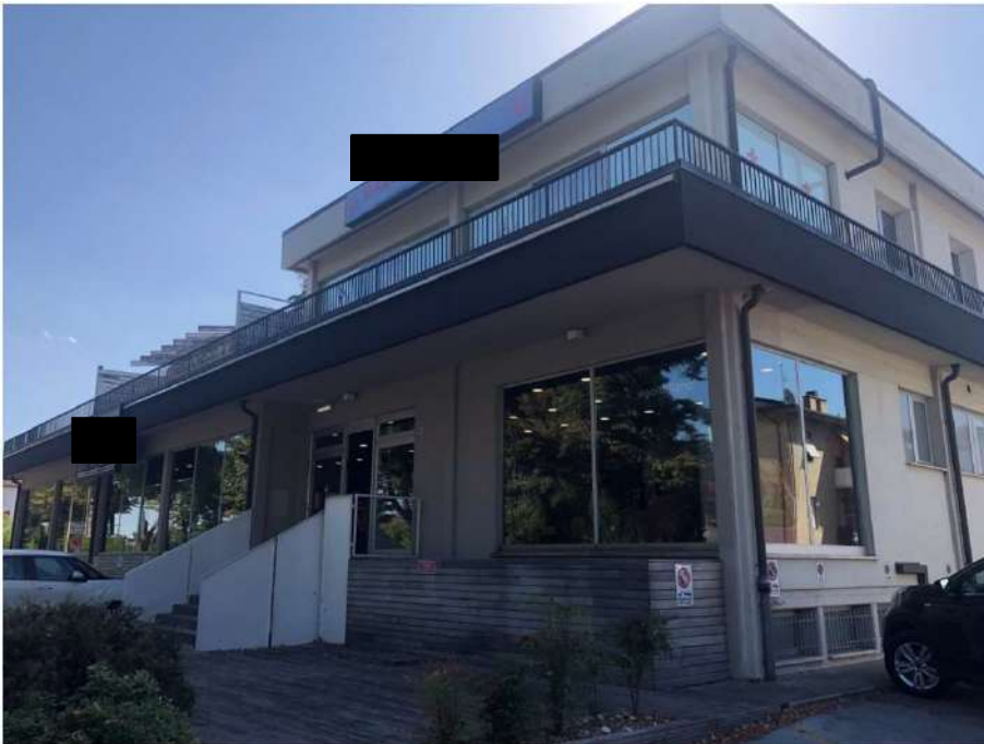
Foto 1 - Prospetto Nord-Est – Viale Roma
