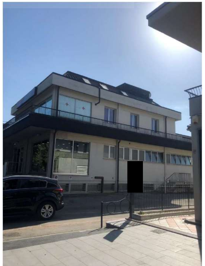
Foto 2 - Prospetto Nord-Ovest – Viale Roma
