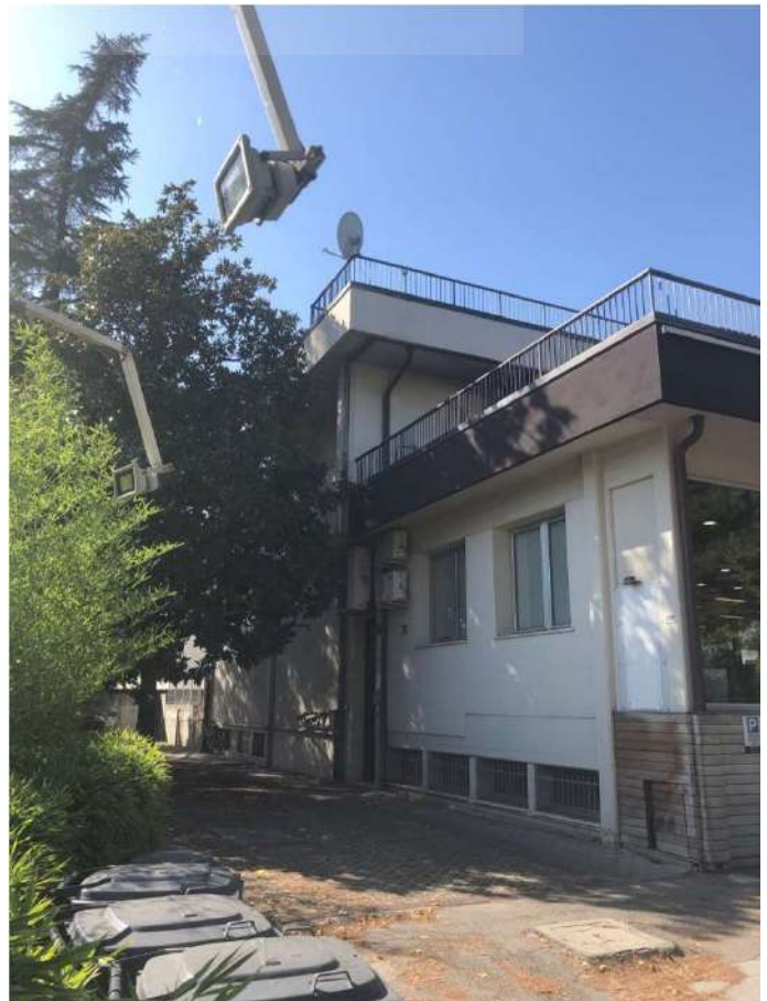
Foto 4 - Prospetto Sud-Ovest – Viale Roma
