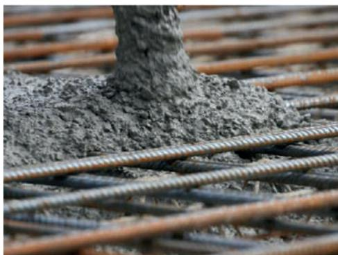
Il getto di calcestruzzo per strutture in fondazione comprenderà l'incidenza per il pompaggio dello stesso, la casseratura, eseguita con tavolato in legname di tipo tradizionale o pannelli in legno lamellare, compreso il disarmo a maturazione avvenuta. L'intervento comprende la fornitura e posa in opera di acciaio certificato per strutture in calcestruzzo armato, in barre dritte e sagomato secondo progetto.
