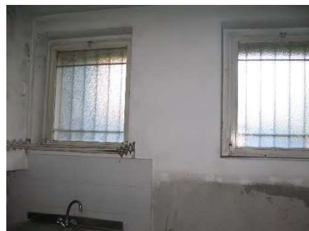
Foto 14 – Interno exautorimessa (PS1)
