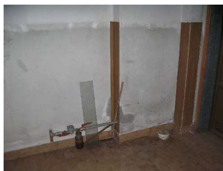
Foto 18 – Interno exautorimessa (PS1)
