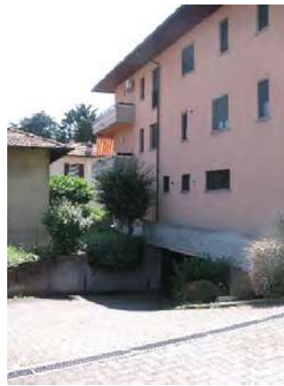
Foto 4 – Vista rampa autorimesse e fronte est
