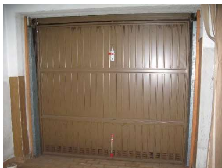
Foto 13 – Interno exautorimessa (PS1)
