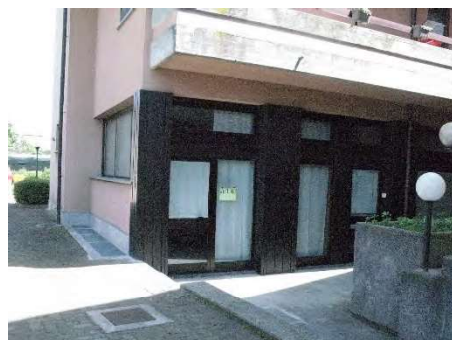
Foto 2 – Vista fronte ovest e nord del negozio
