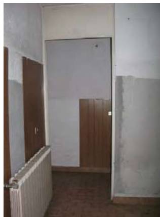
Foto 16 – Interno exautorimessa (PS1)
