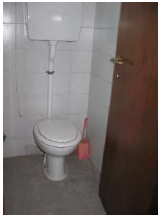
Foto 10 – Interno bagno (PT)
