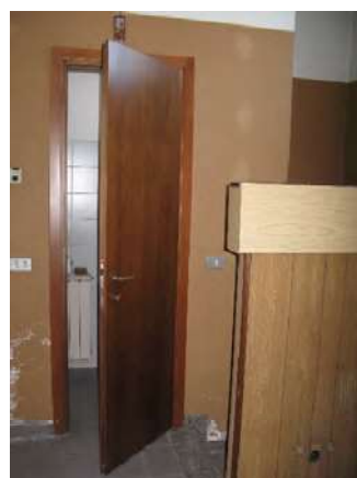
Foto 8 – Interno negozio (PT)
