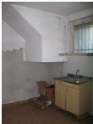
Foto 15 – Interno exautorimessa (PS1)
