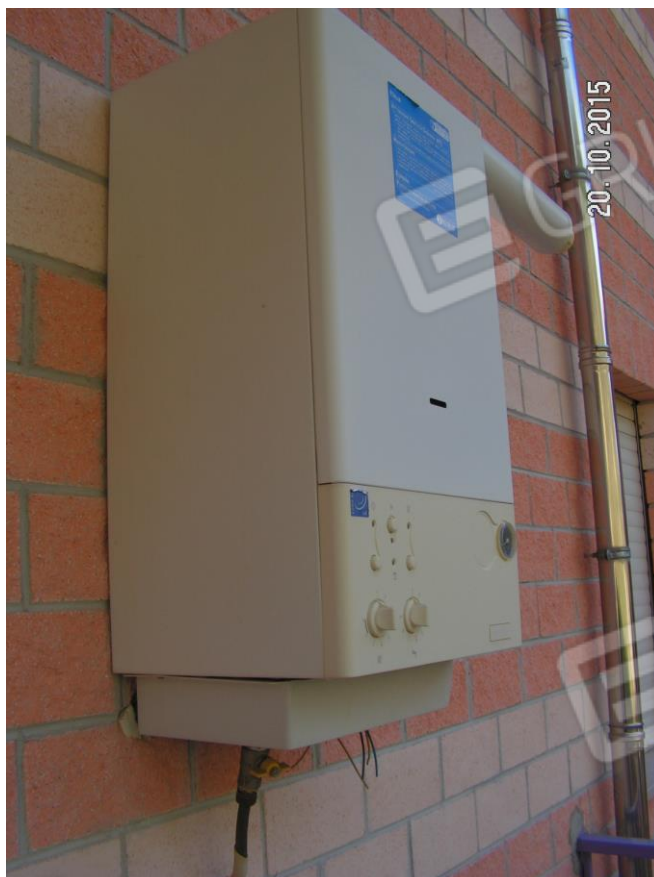
Immagine 14 – particolare interni Caldaia
