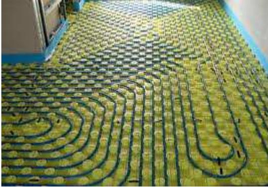
Progettato per temperature - 10°/+20° del tipo a pavimento con integrazione di un calorifero nei bagni come previsto da progetto esecutivo depositato presso il Comune di Caraglio. Sarà realizzata una sola centrale termica nel sottotetto nel rispetto della normativa vigente al momento della sua realizzazione. La rete di distribuzione alimenterà le singole unità abitative dotate di
