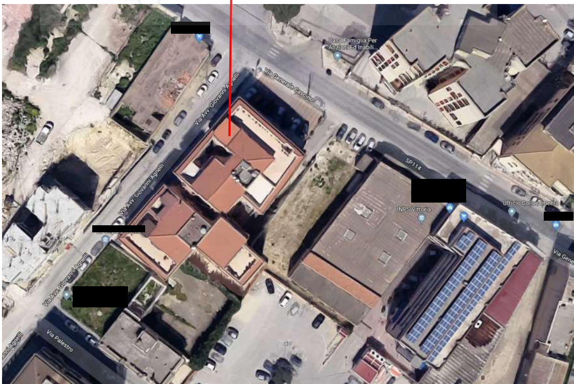
Figura n. 2.4 : Foto satellitare dell'unità immobiliare oggetto di stima
