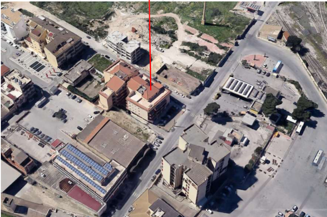
Figura n. 2.6 : Foto satellitare dell'unità immobiliare oggetto di stima
