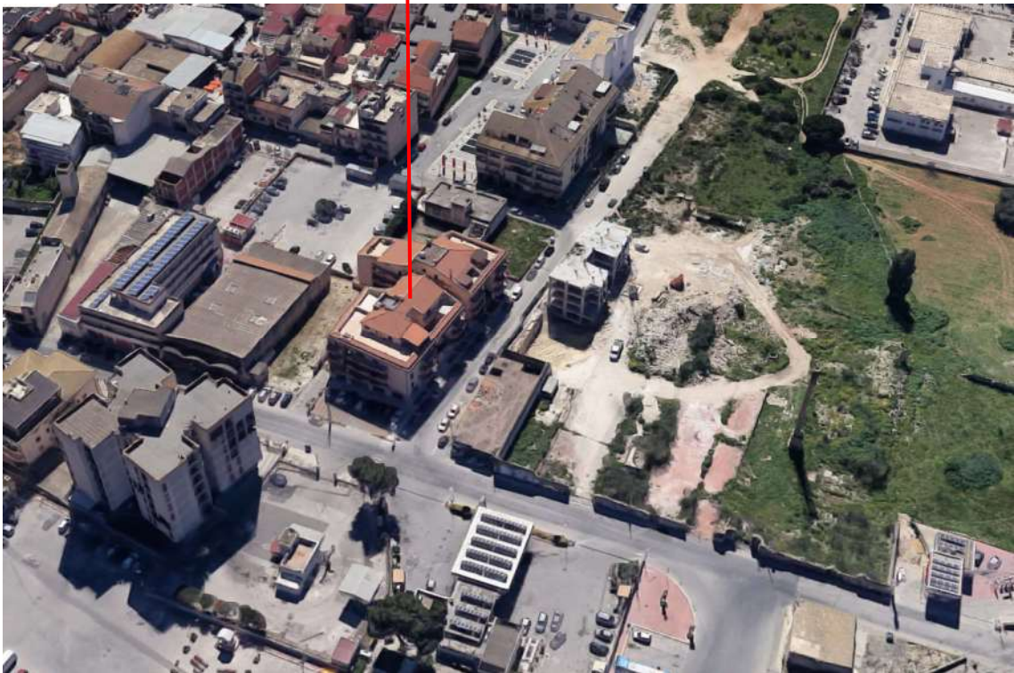
Figura n. 2.5 : Foto satellitare dell'unità immobiliare oggetto di stima
