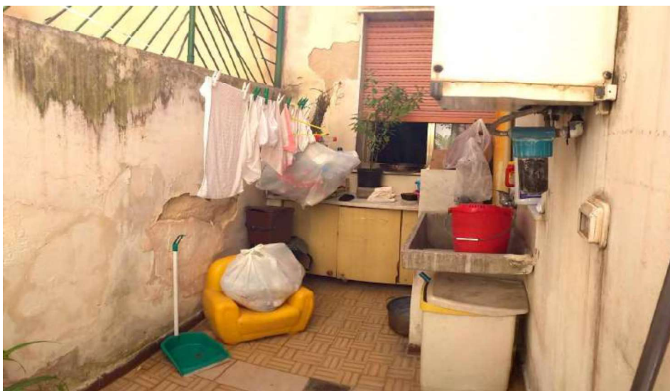
Foto 10 Cavedio piano terra appartamento Foglio 210 Vittoria particella 8119 sub 2
