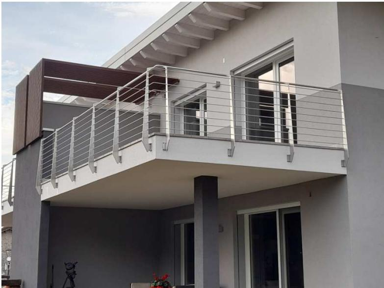
**PARAPETTI dei balconi** realizzati in **acciaio inox** con tondini diam. 12 mm H 1050 mm con fissaggio su soletta
