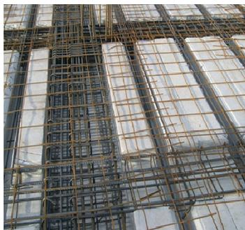
I solai dei piani fuori terra e balconi-terrazzi sono realizzati con termosolaio.
