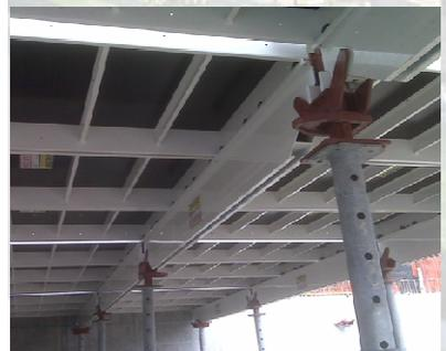
Solaio di copertura del piano interrato nella tipologia Palazzina sarà realizzato con getto in cls pieno, con cassero autoportante, con intradosso faccia a vista da non intonacare, con le caratteristiche di resistenza al fuoco non inferiore a REI 120. Sia per i calcestruzzi, forniti in cantiere con autobetoniere e gettati con autopompe e/o con benna gru, che per le barre di armatura saranno effettuati i prelievi e le relative prove materiali indicati dalla D.L.
