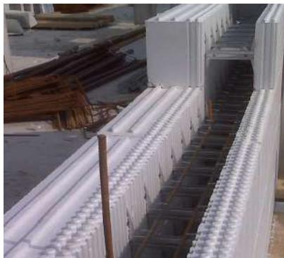
Le strutture in elevazione primaria sono realizzate con un metodo costruttivo costituito da casseri isolanti a perdere, con i quali si ottengono pareti in calcestruzzo.
