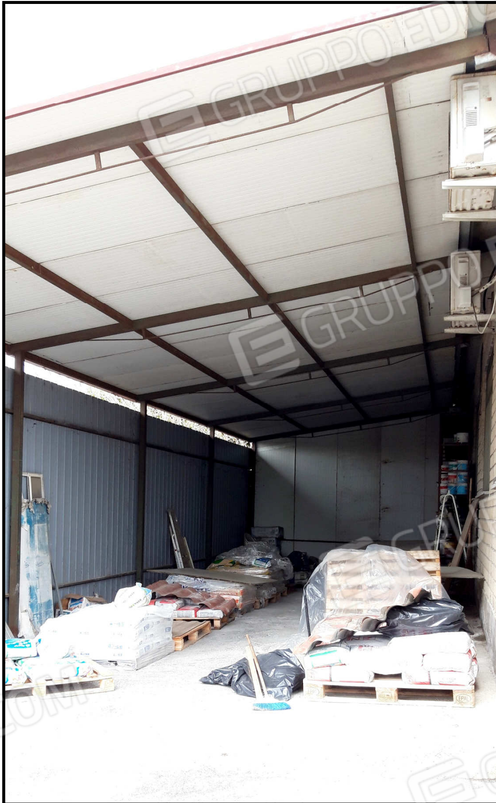
Foto 33: La tettoia realizzata in difformità al progetto sul lato ovest del capannone part. 417.
