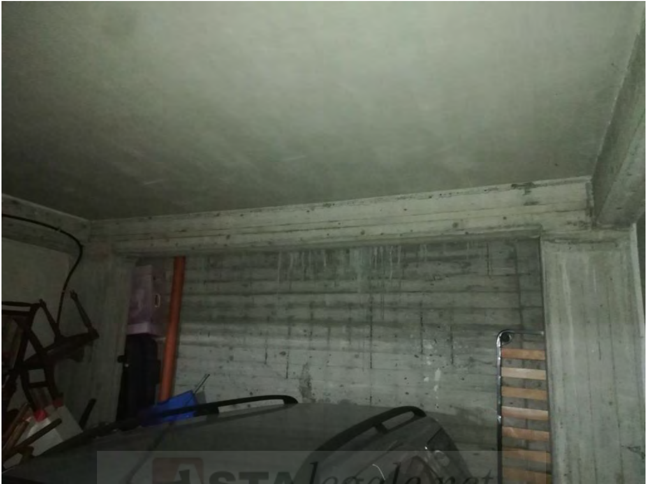
Foto 7 – Interno del locale di deposito
