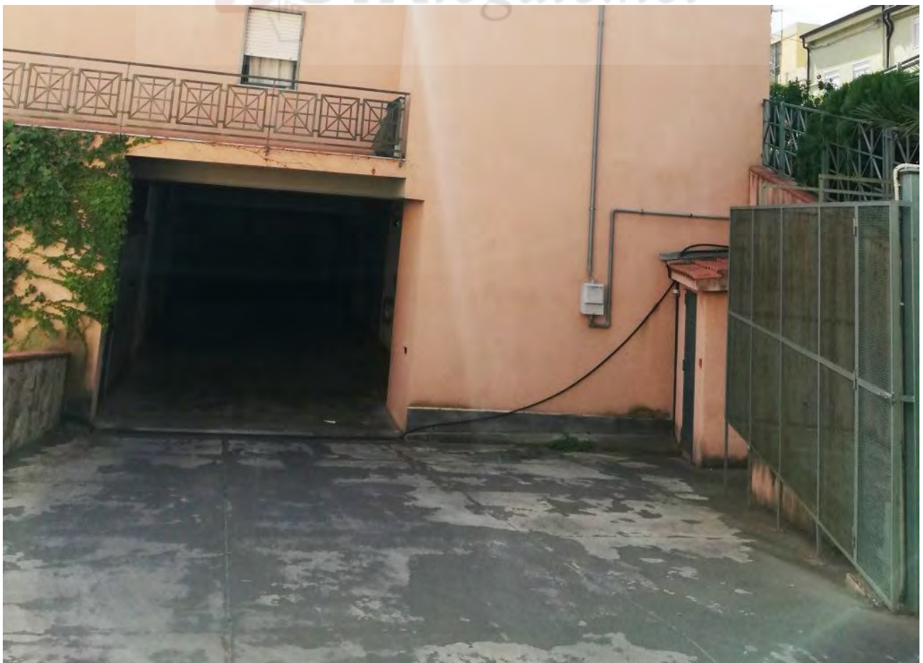
Foto 4 – Rampa di accesso alla corsia che conduce all'immobile pignorato
