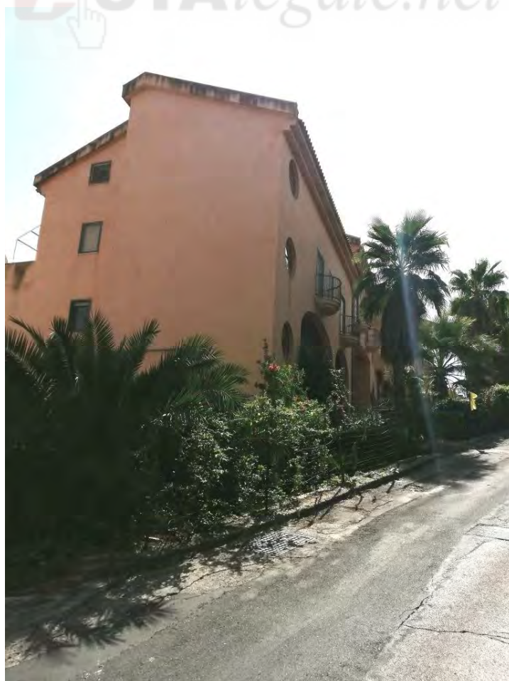
Foto 2 – edificio in cui ricade l'immobile pignorato
