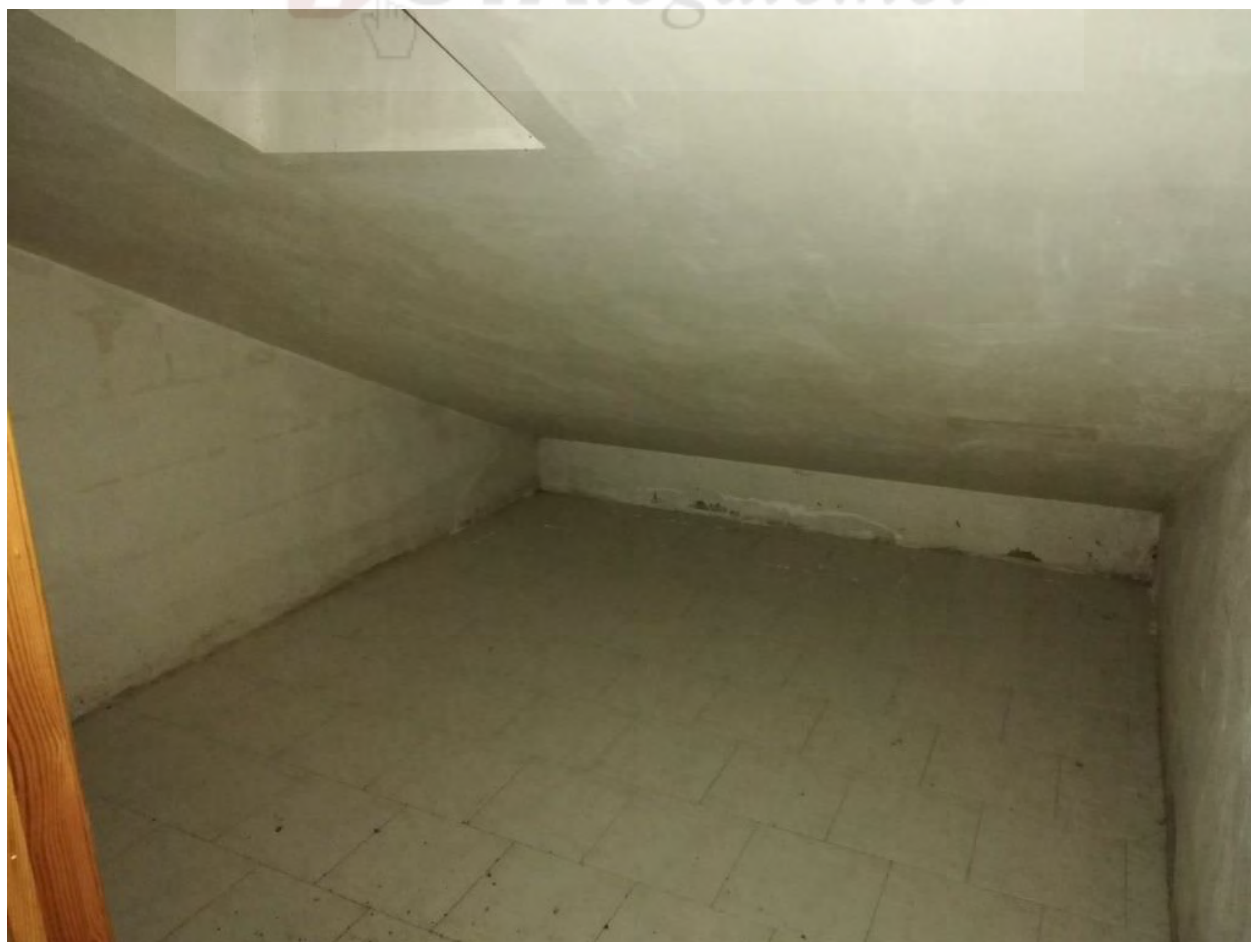
Foto 4 – Interno del locale di sgombero (sub. 13)
