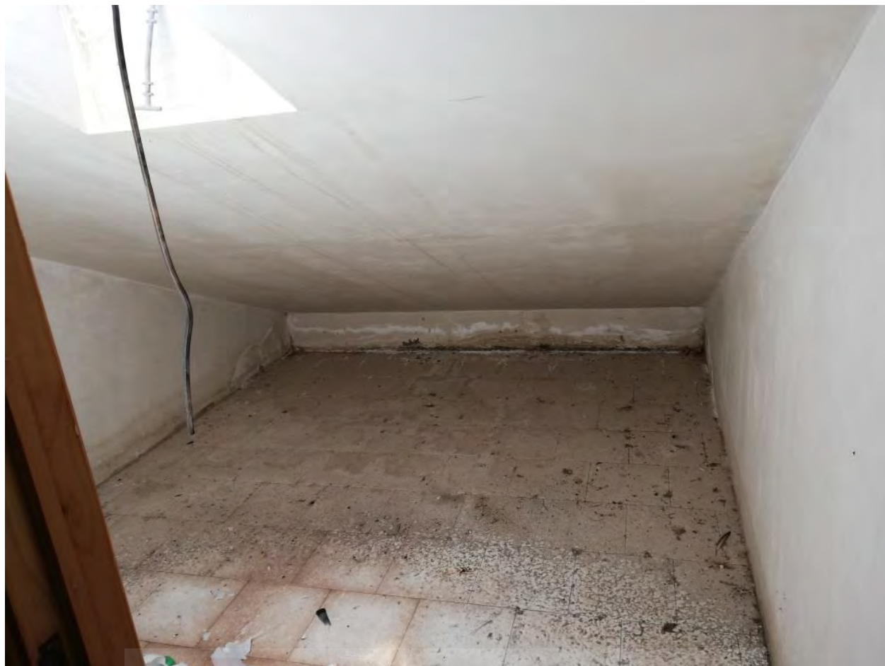
Foto 3 – Interno del locale di sgombero (sub. 14)
