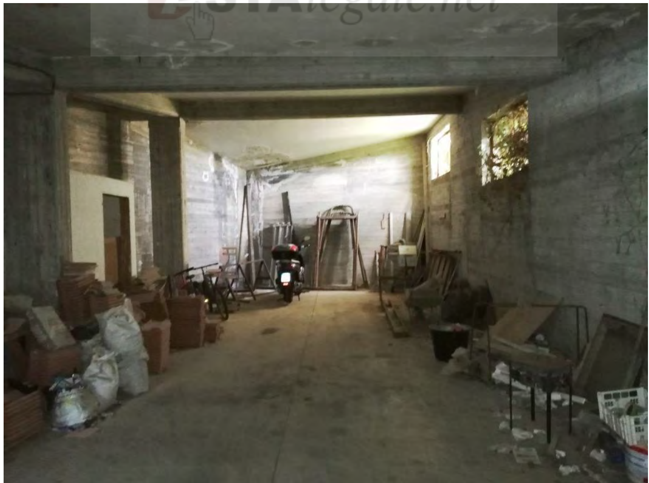
Foto 6 – Interno del locale di deposito
