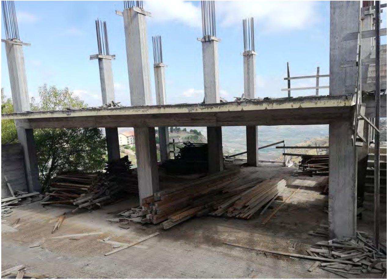
Foto 15 – Interno, piano terra dell’edificio in corso di costruzione
