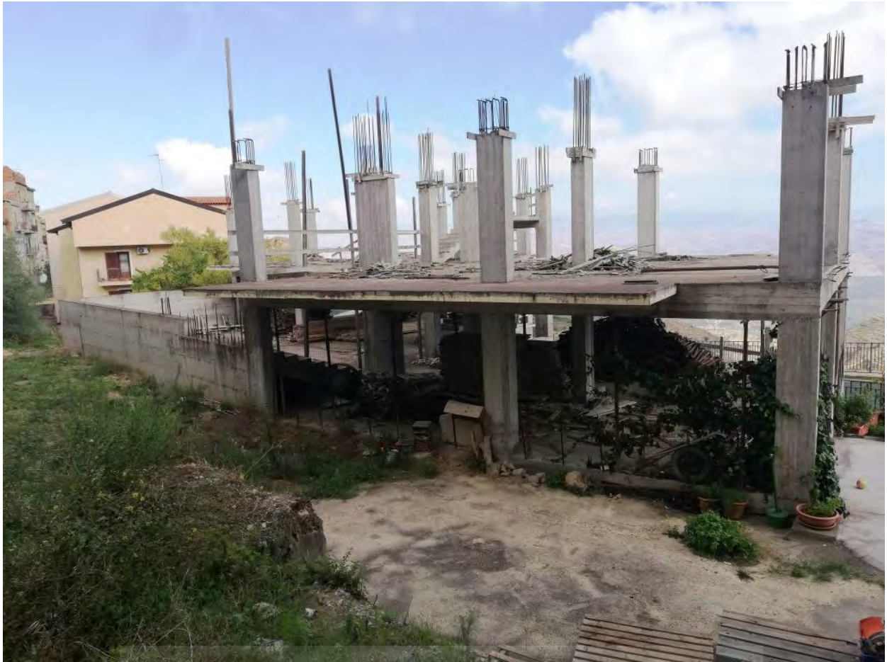
Foto 5 – Prospetto sud-ovest dell'edificio
