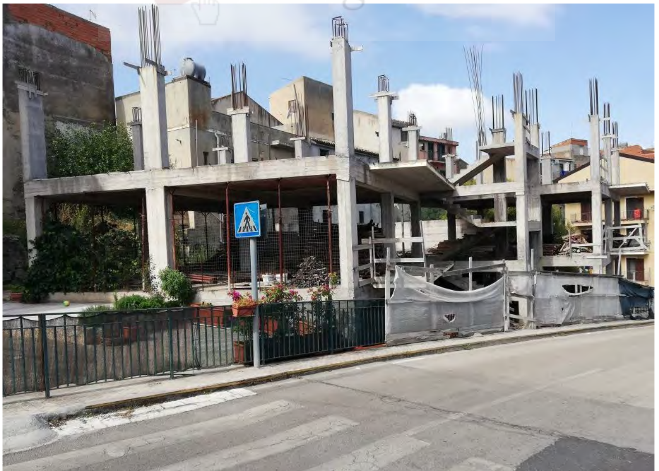
Foto 2 – Prospetto sud-est dell'edificio
