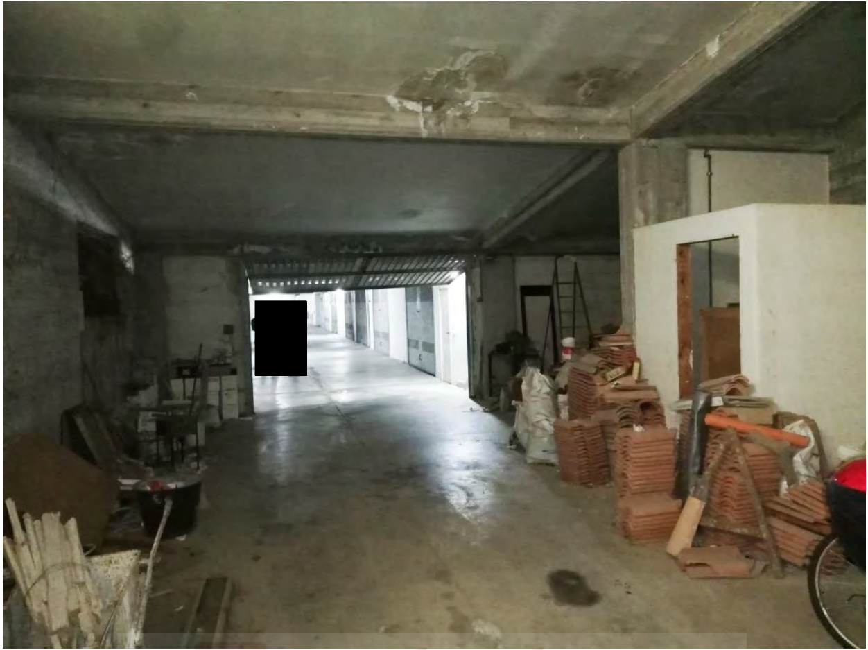
Foto 7 – Interno del locale di deposito
