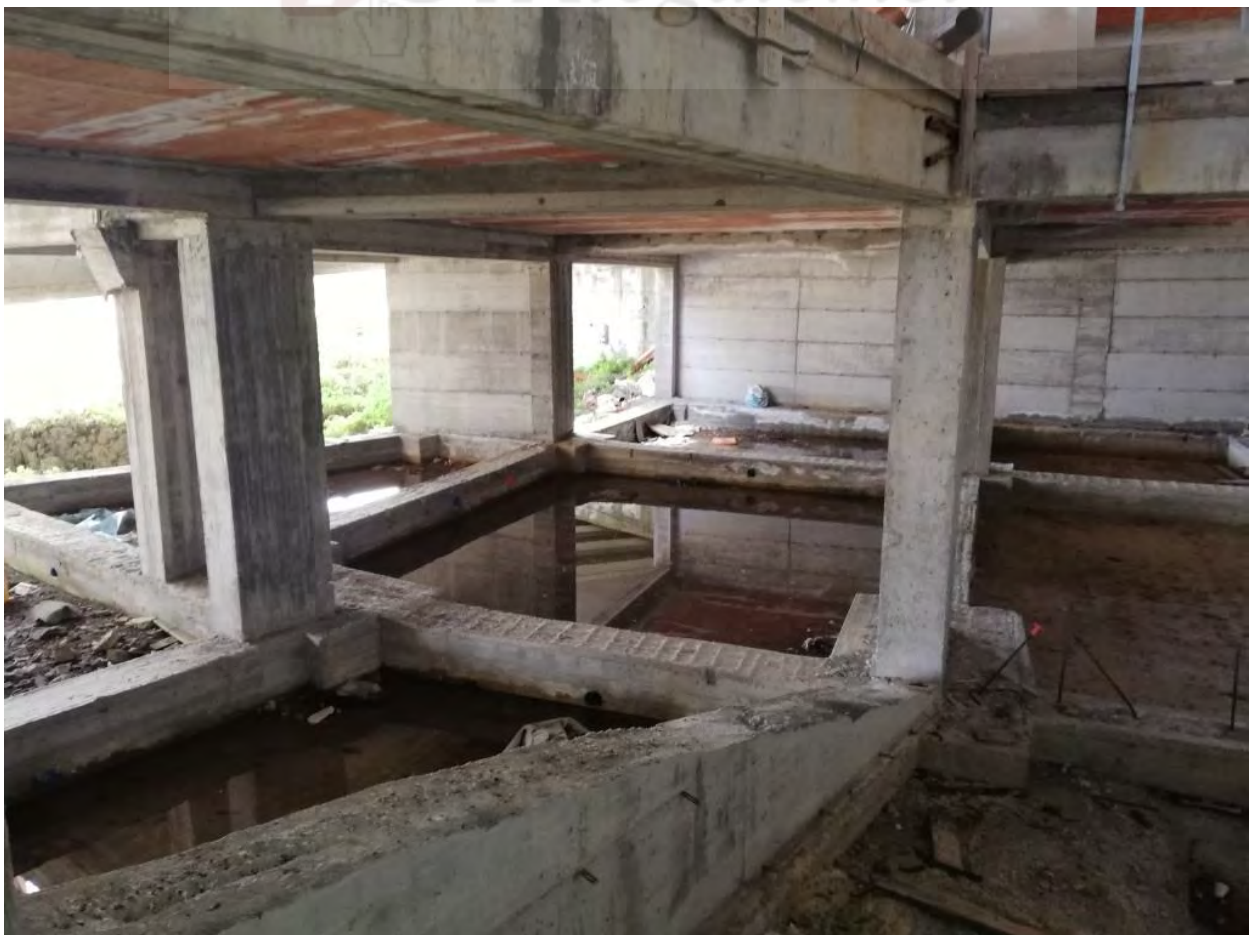
Foto 10 – Interno, secondo piano seminterrato dell'edificio in corso di costruzione
