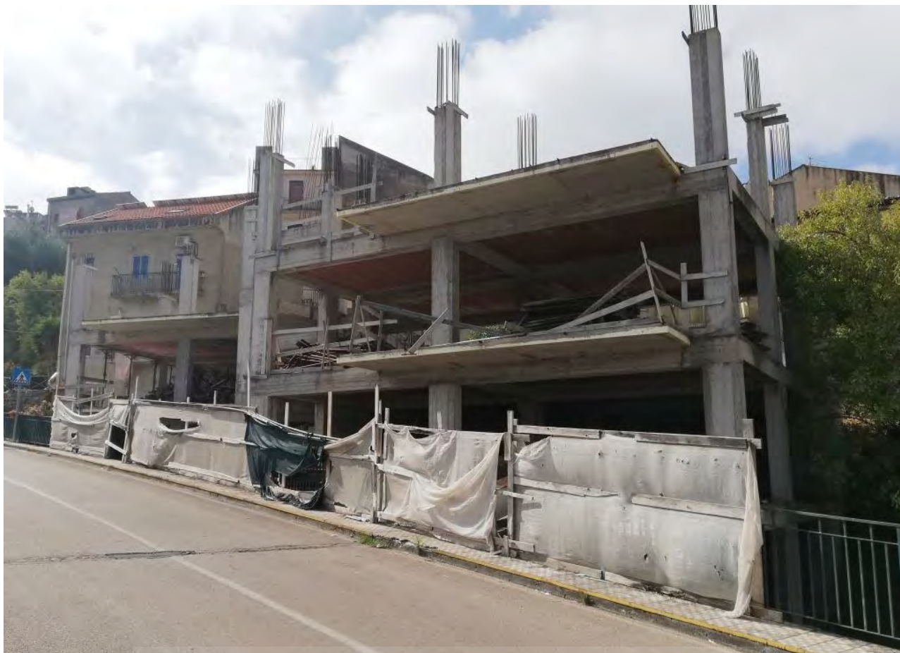
Foto 3 – Prospetto nord-est dell'edificio
