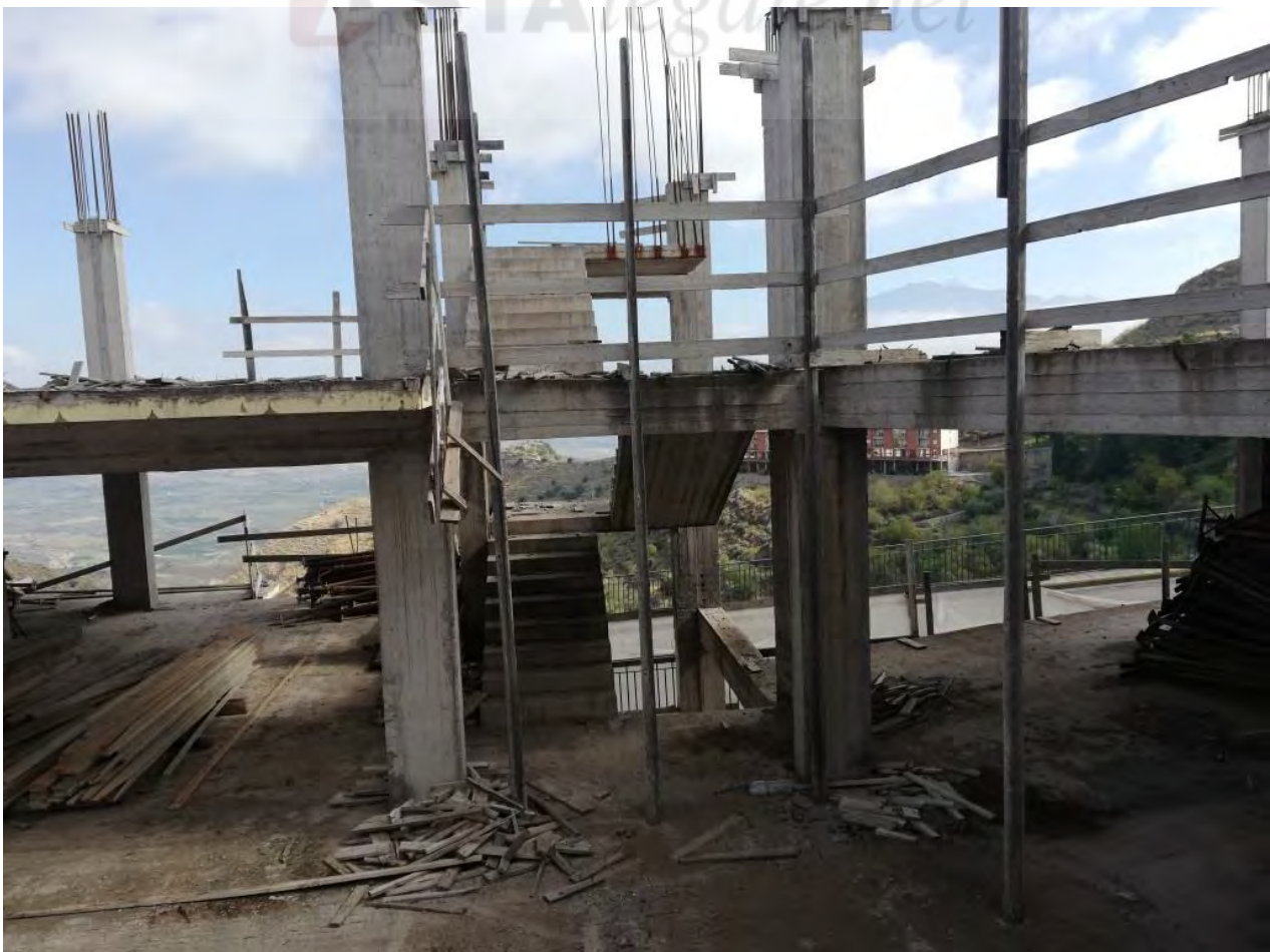
Foto 16 – Interno, vano scala
