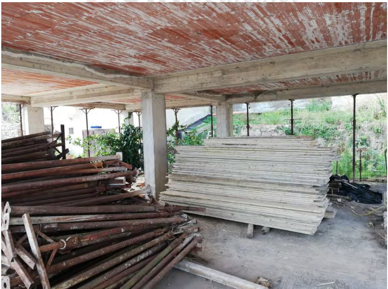
Foto 14 – Interno, piano terra dell'edificio in corso di costruzione
