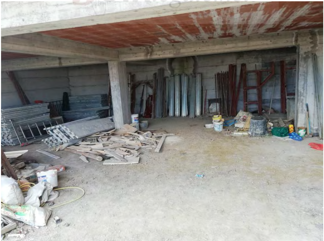
Foto 12 – Interno, primo piano seminterrato dell'edificio in corso di costruzione
