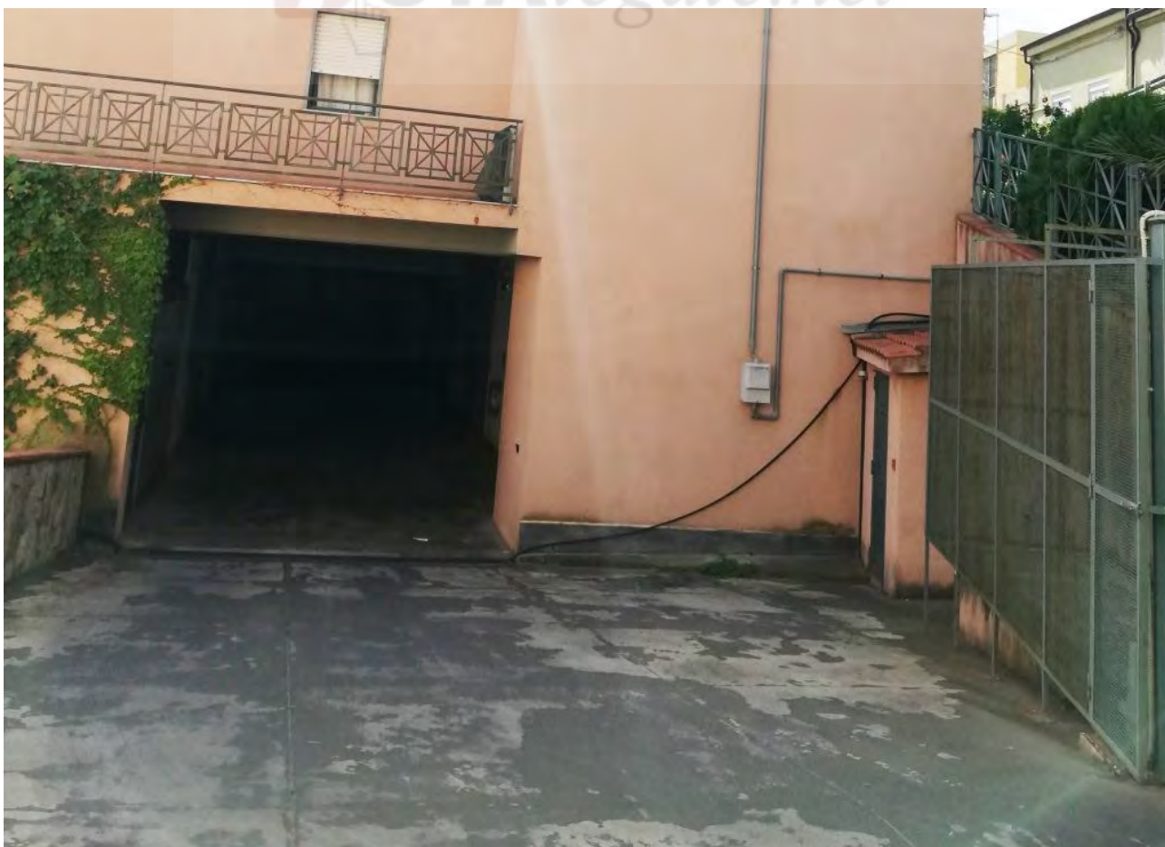
Foto 4 – Rampa di accesso alla corsia che conduce all'immobile pignorato
