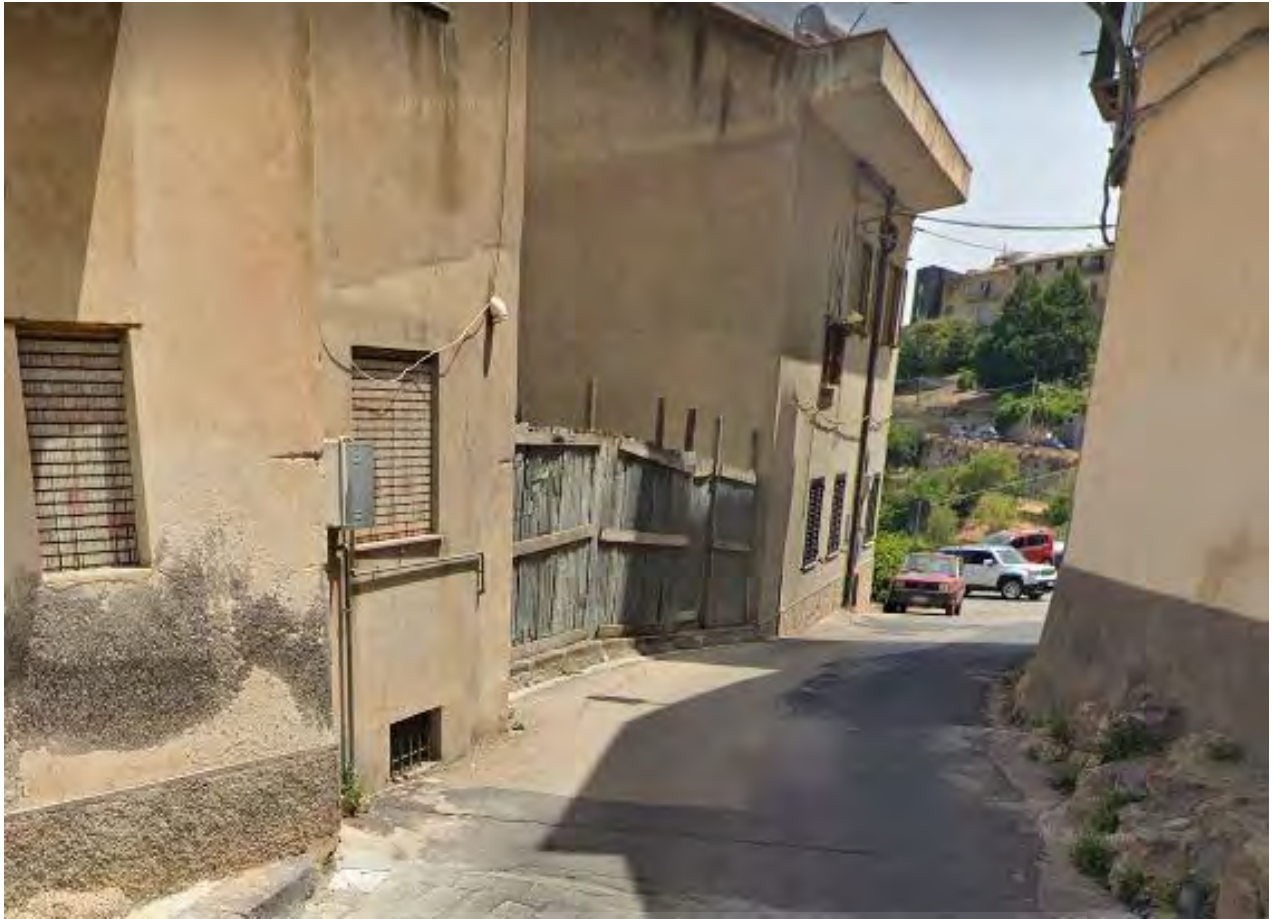
Foto 7 – Accesso da via Napoli (lato esterno) ancora da realizzare
