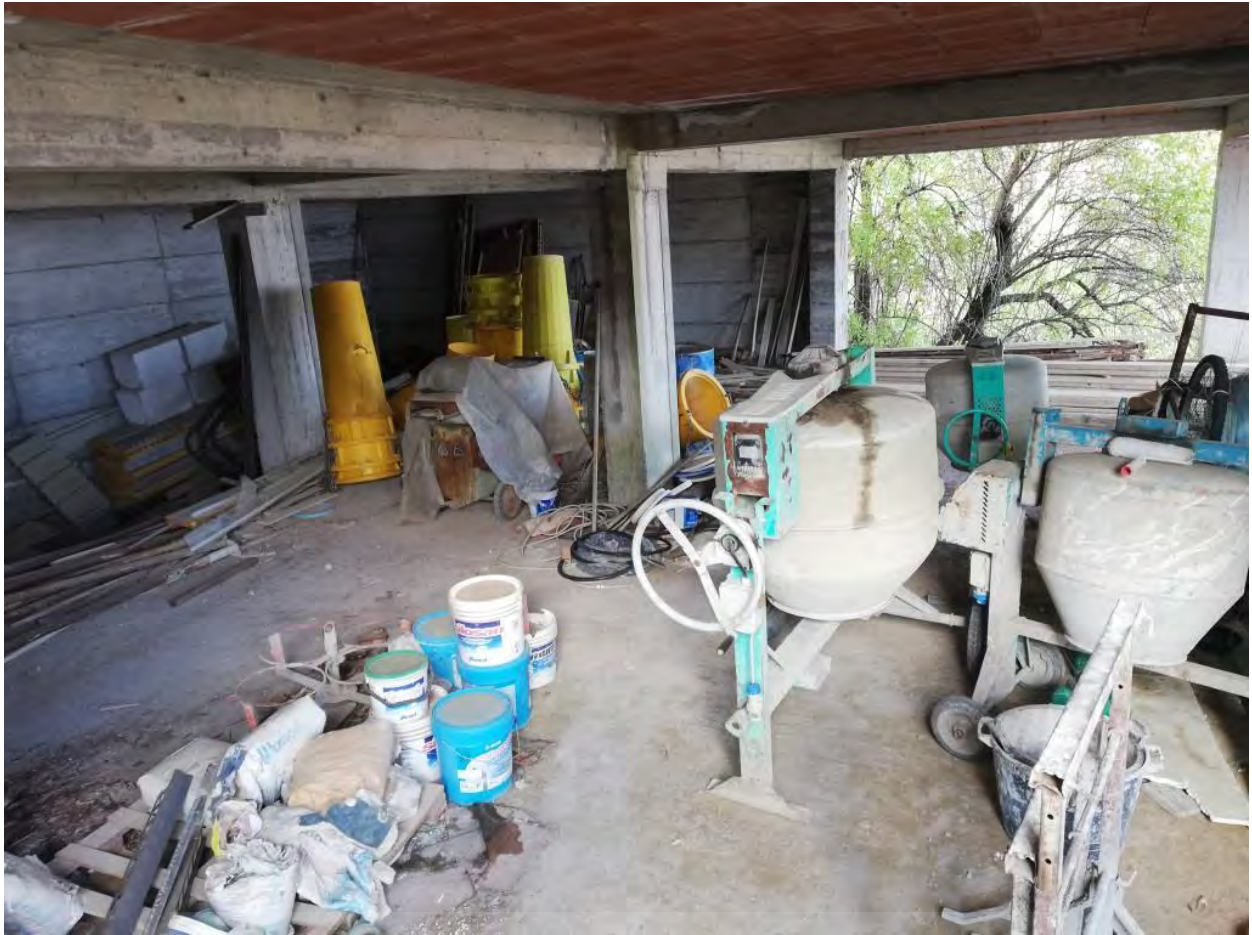
Foto 13 – Interno, primo piano seminterrato dell'edificio in corso di costruzione
