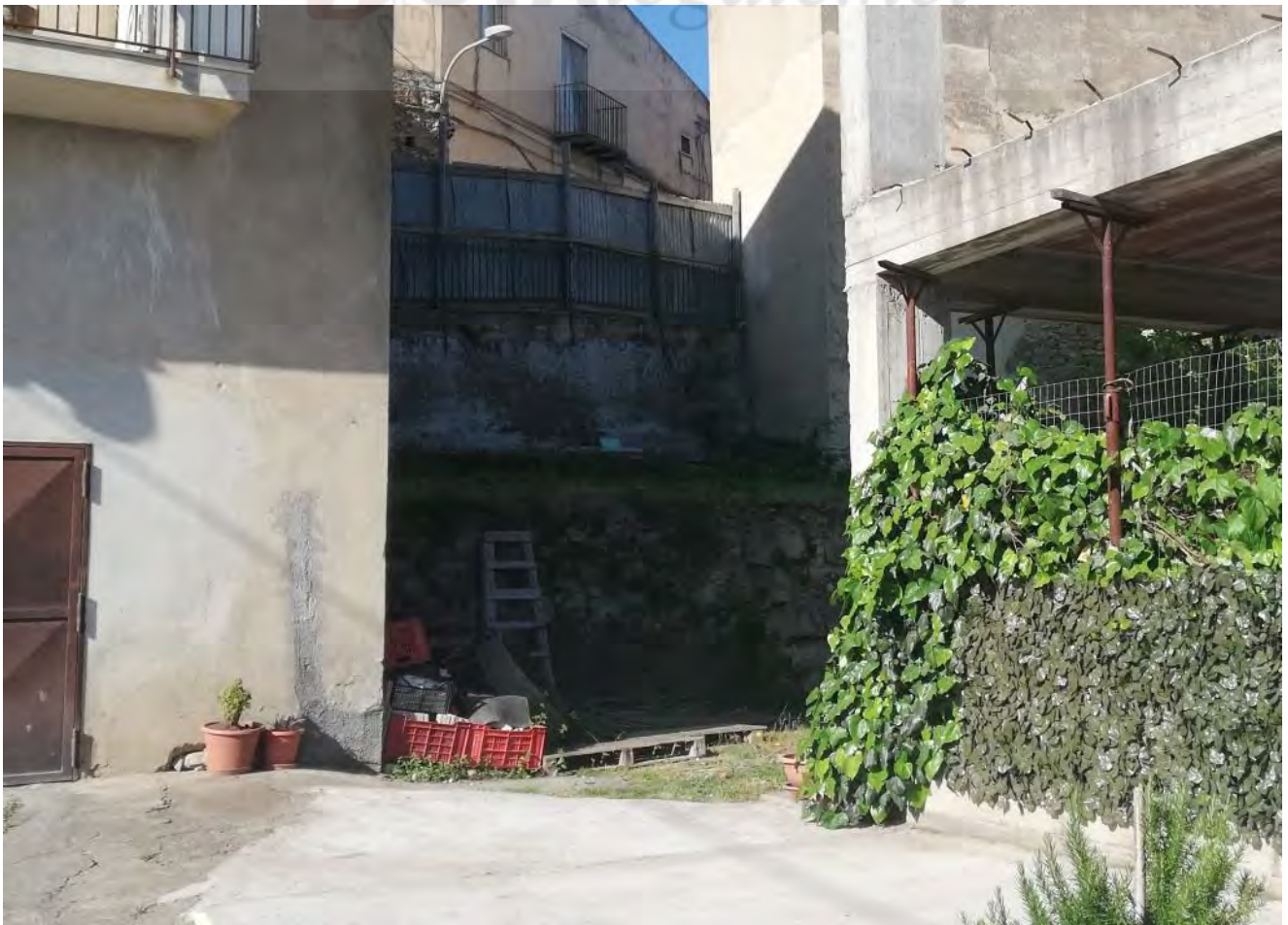
Foto 6 – Accesso da via Napoli (lato interno) ancora da realizzare
