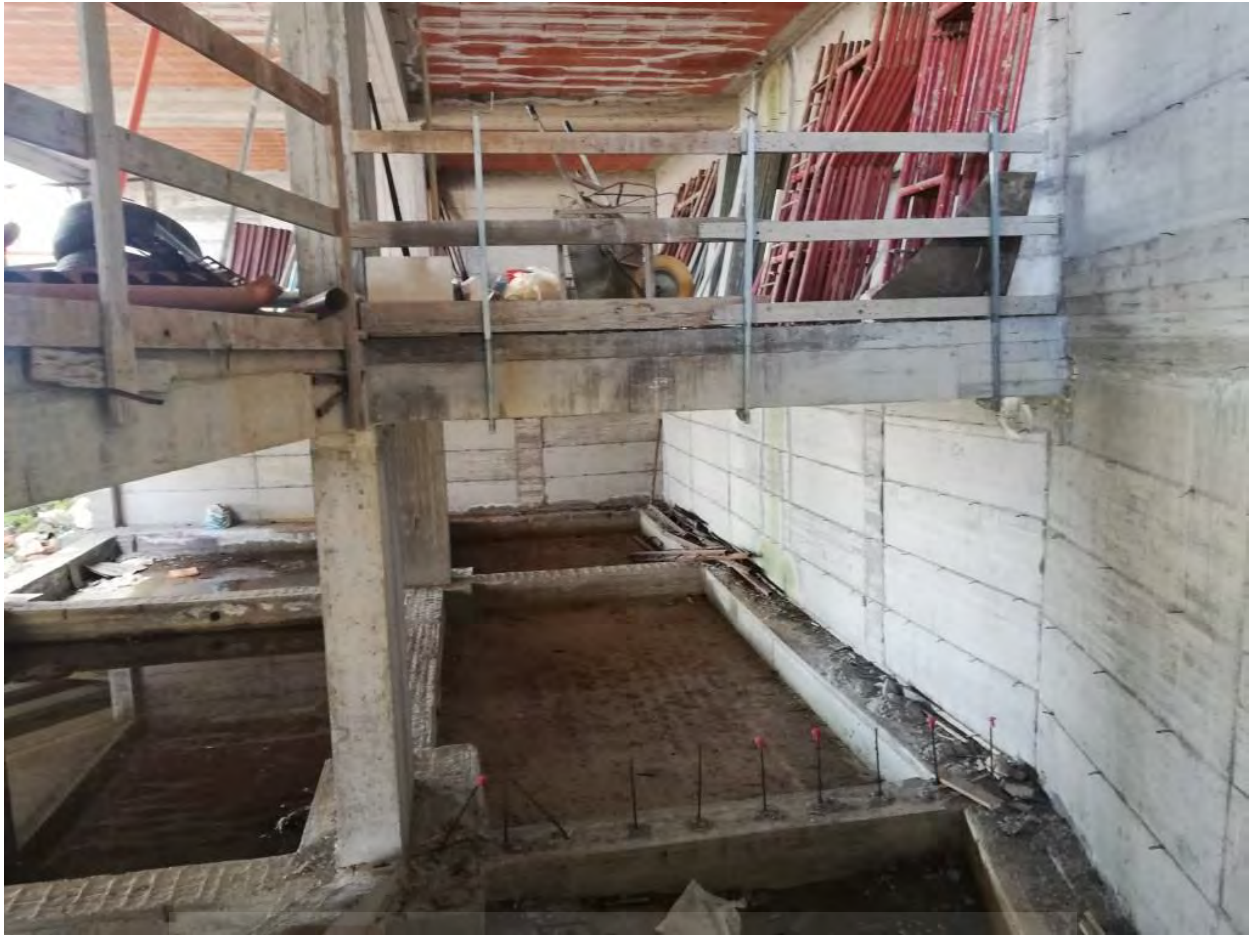
Foto 11 – Interno, secondo piano seminterrato dell'edificio in corso di costruzione
