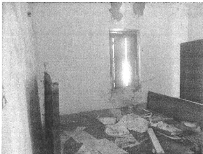
Camera al piano primo lato nord-ovest
