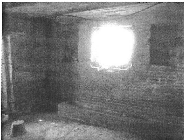
Locale stalla al piano sottostrada
