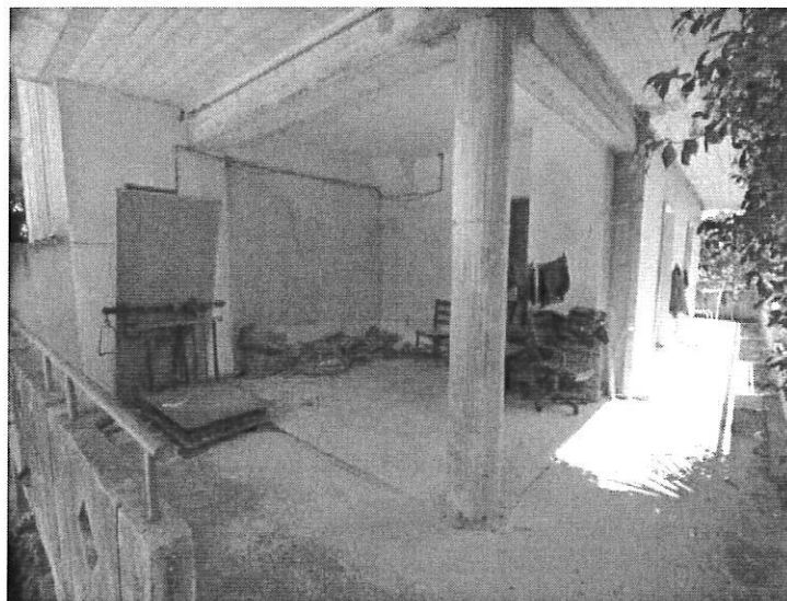
Terrazza angolo sud/ovest e balcone lato sud
