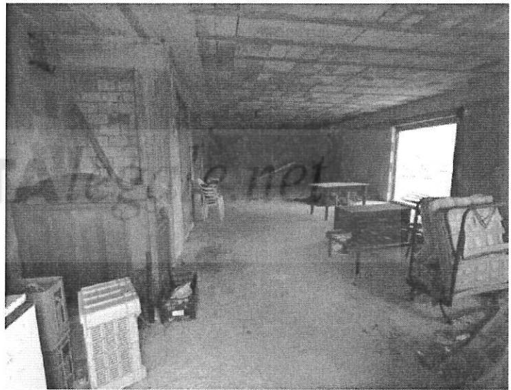
Abitazione grezza al piano terra
