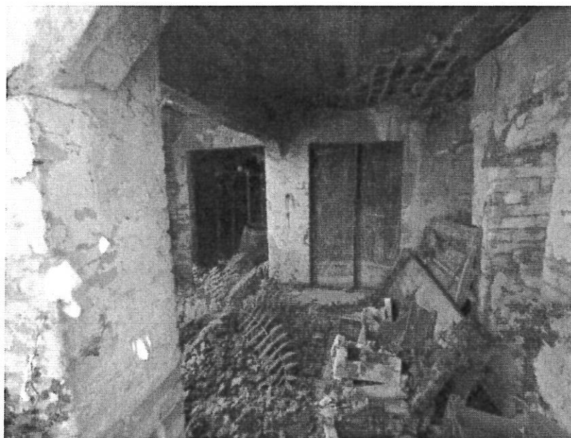
Locale rimessa al piano sottostrada
