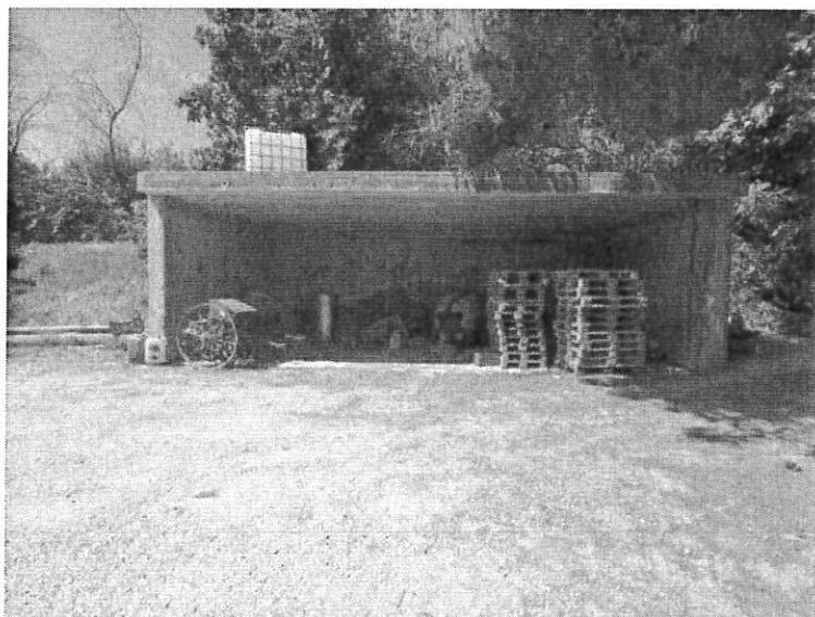
Manufatto esterno al piano terra
