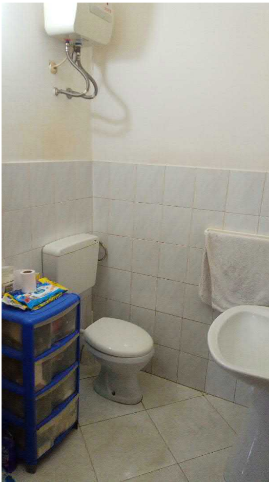
FOTO 7_WC ANNESSO ALLA CUCINA PT
