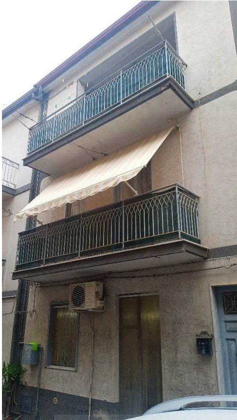
PROSPETTO VIA BARBAGALLO 12
