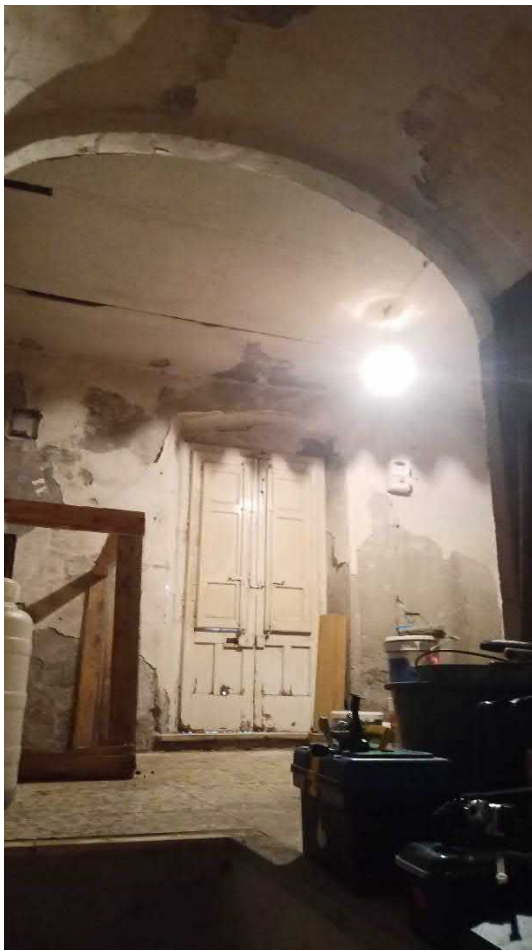
FOTO 11_LOCALE DI SGOMBRO PT
