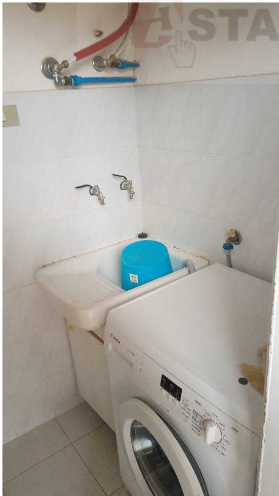
FOTO 29_WC LAVANDERIA P2
