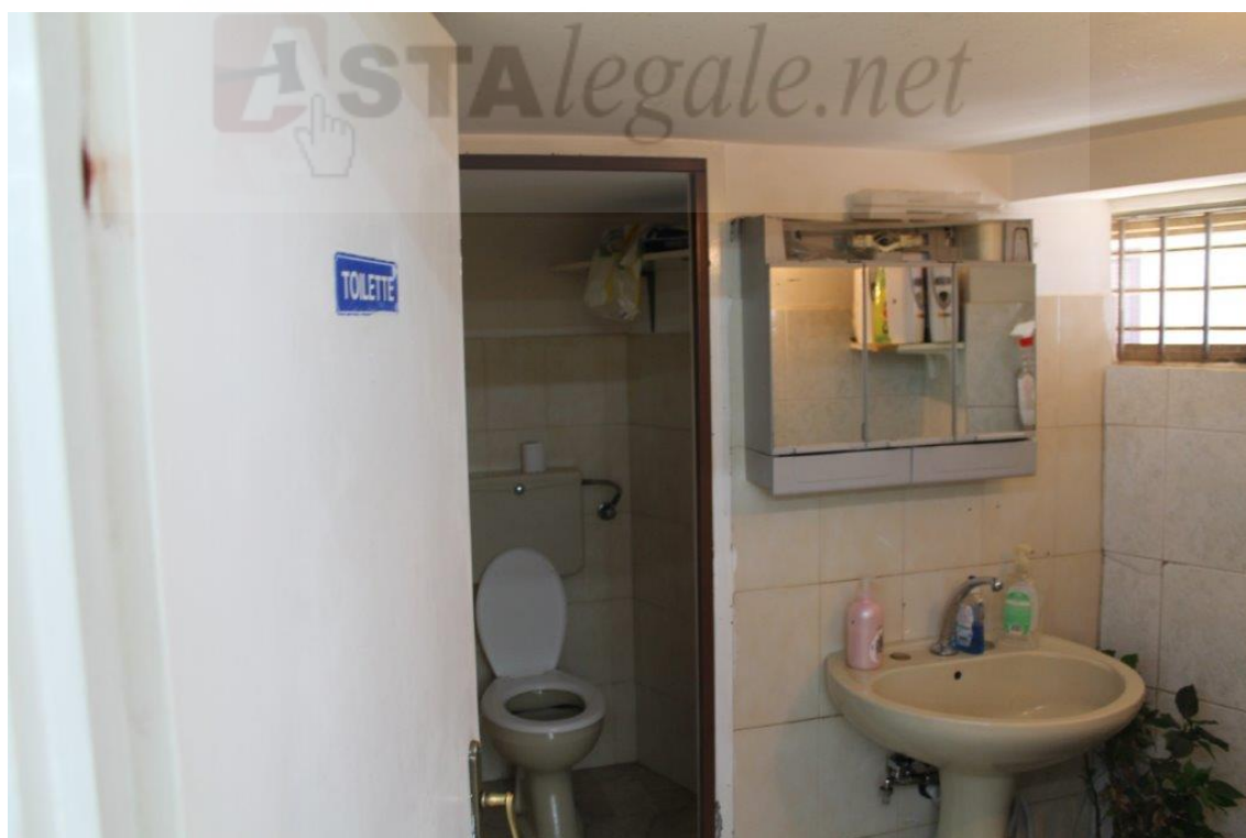
Foto 10 – Ambiente 5 (Disimpegno w.c.)
