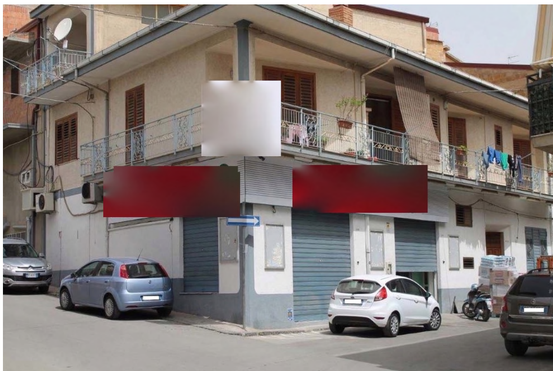
Foto 1 – vista immobile (sub 3 appartamento piano primo) Angolo via Ferreri G. e Corso Italia
