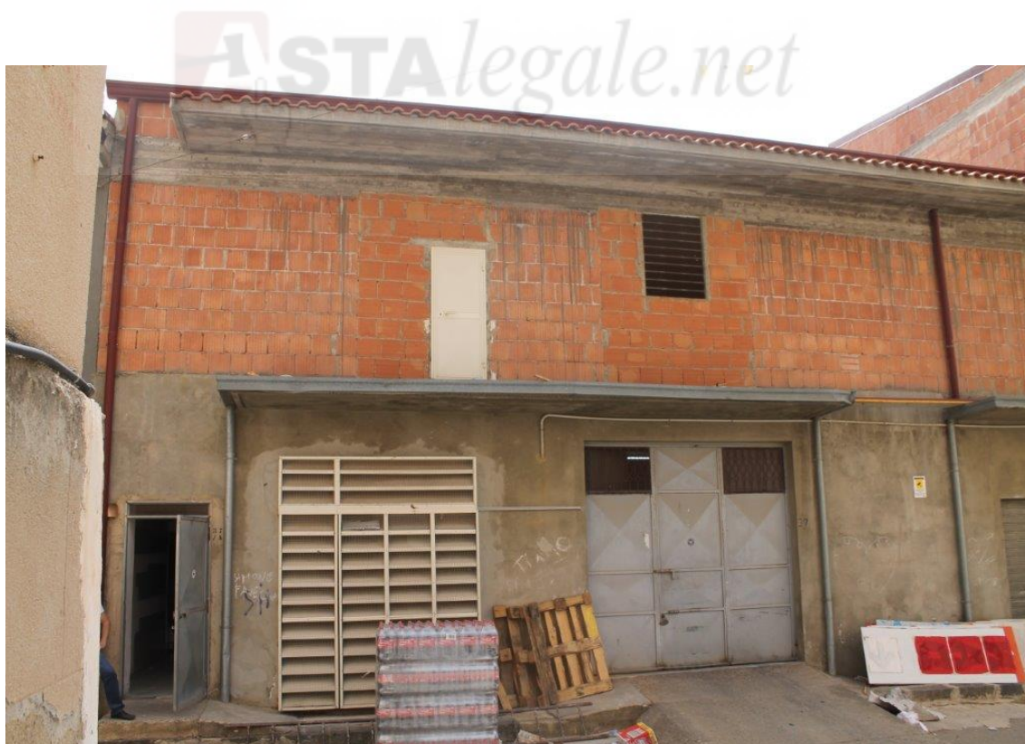
Foto 2 – vista ESTERNA (sub 4 magazzino piano terra) via F. Cordova
