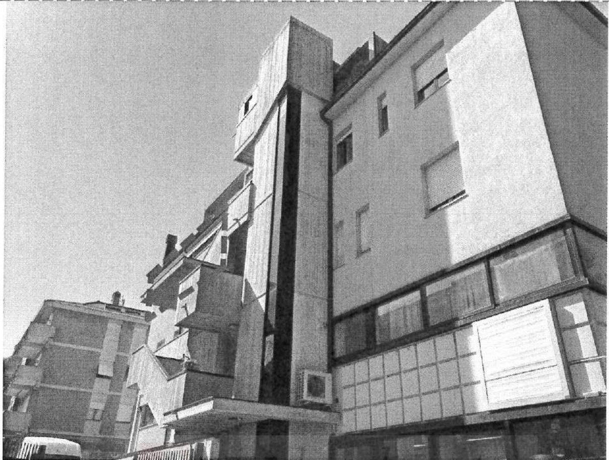
Foto 3 – lato Est da corte d'accesso comune
