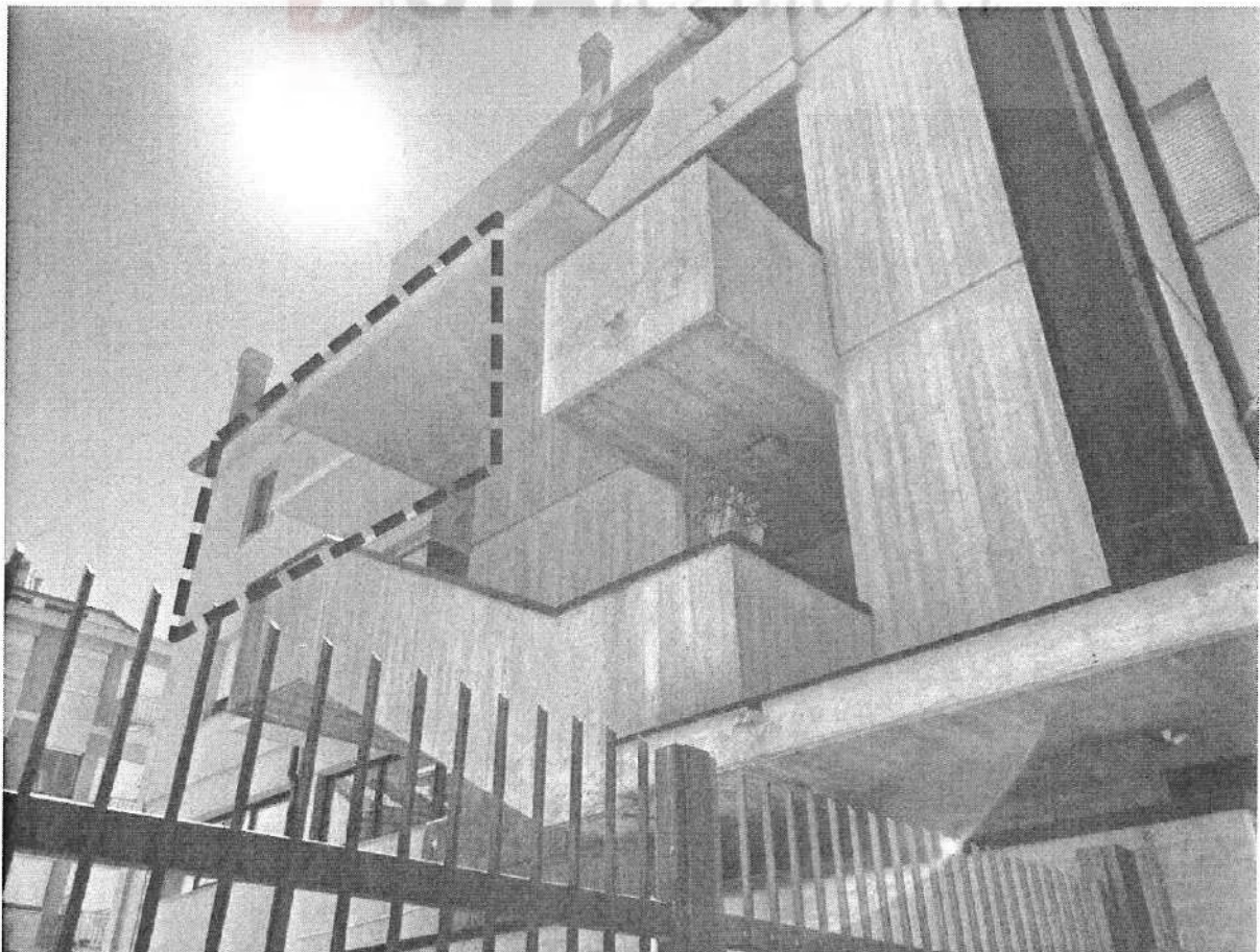
Foto 4 – scala esterna ed ascensore comuni visti dalla corte d'accesso comune lato Est
