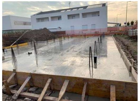
**Pilastri, travi in spessore e fuori spessore, cordoli**, dove necessari, in calcestruzzo armato con criteri antisismici della zona di appartenenza con superfici non a faccia vista, sia all'interno delle murature che casserati nei 4 lati, il tutto per un'altezza massima continua non superiore a 3 ml, in ottemperanza a quanto riportato nelle tavole statiche del calcolatore.
