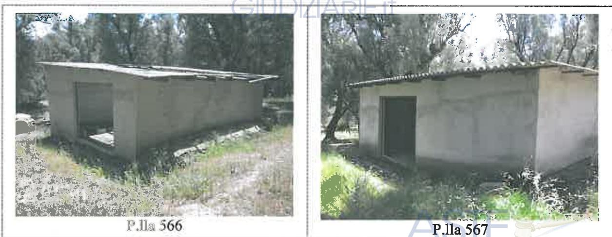
L'immobile identificato con il mappa 566 è stato realizzato in muratura portante con manto di copertura in lastre ondulate di lamiera zincata su piccola orditura in legno. Il pavimento risulta in massetto di cemento al grezzo. L'immobile risulta privo di infissi e la copertura in parte è crollata. L'immobile è privo di tutti gli impianti.
