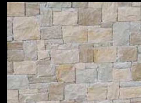
Parziale rivestimento dei muri esterni con PIETRA DI CREDARO a taglio squadrato posata a semisecco
