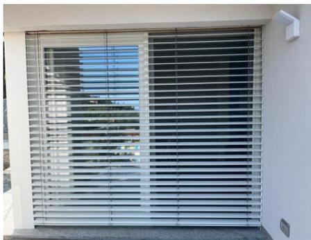
Frangisole con movimentazione tramite nastri di trazione e orientamento.
